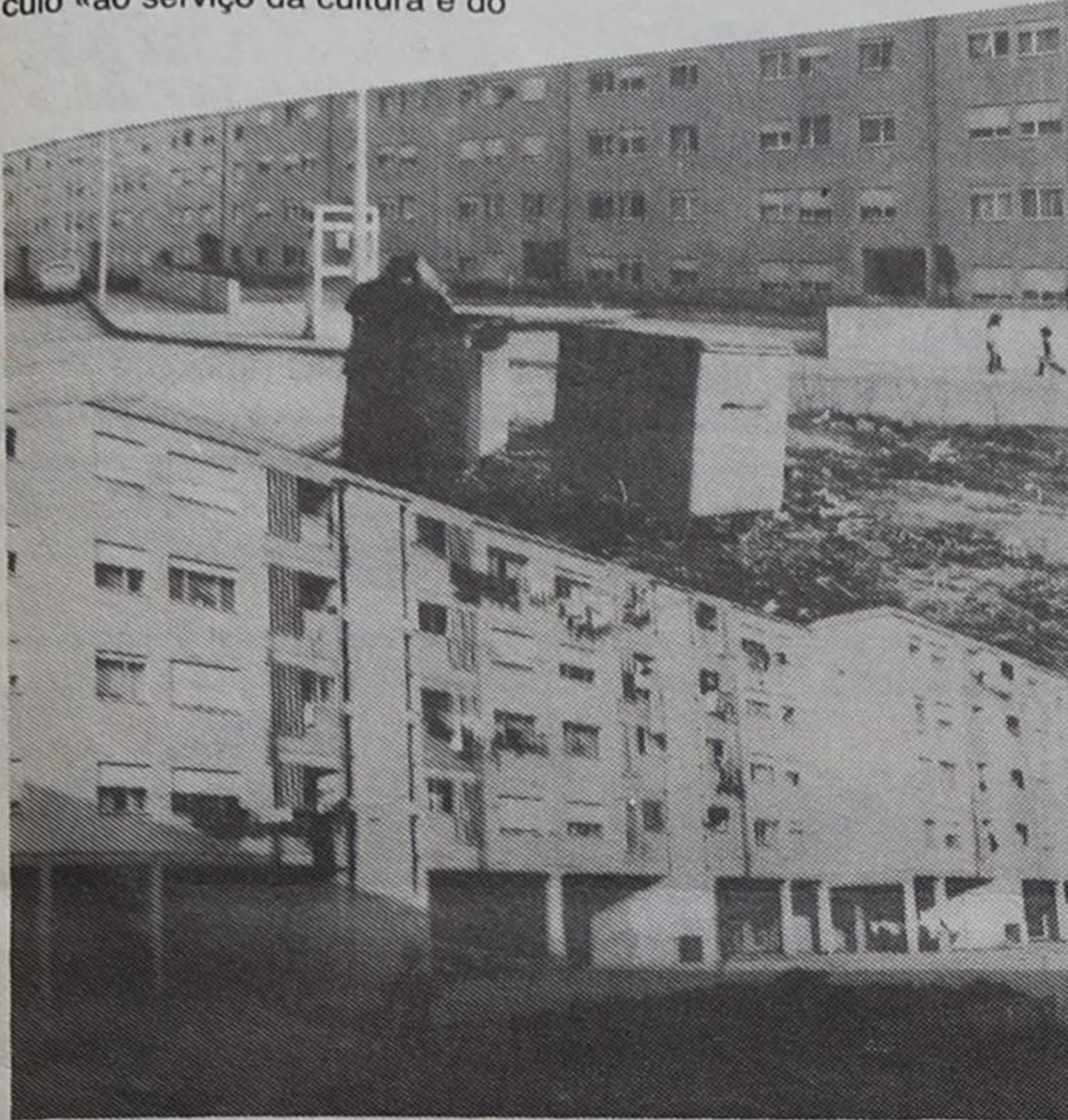
Conjunto habitacional da Ponte de Anta. Com os 54 fogos em construção e os 56 previstos para breve, aquela cidade-satélite terá em breve uns dois mil habitantes
