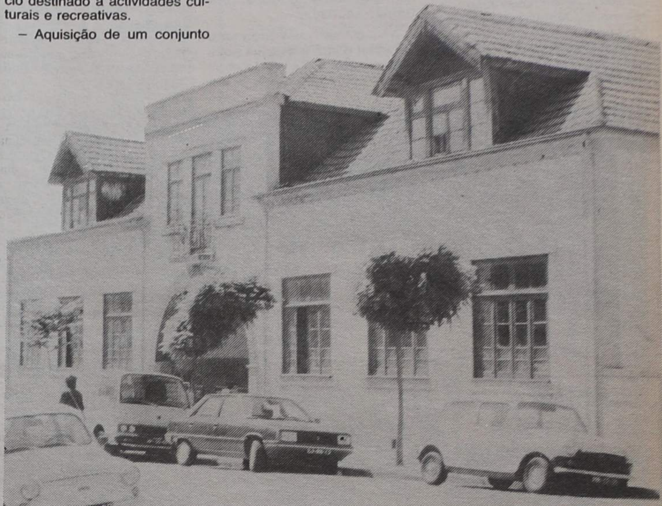
A Junta urbana não desiste de encontrar «a melhor solução» visando construir um imóvel que aloje os seus serviços e as colectividades — imóvel que surgirá na Rua 23, onde agora se situa esta escola
