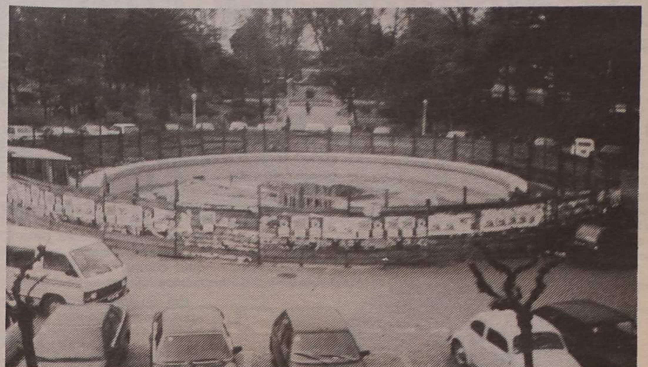
Este o estado actual das obras relativas à fonte luminosa, no Largo dr. José Salvador, frente à Câmara Municipal. Os trabalhos têm vindo a sofrer alguns atrasos (o mármore chega às pinguinhas) mas com um «forcing» talvez se consiga inaugurar a obra no dia 23 de Maio — quando passa precisamente um século sobre a data da criação da freguesia espinhense
