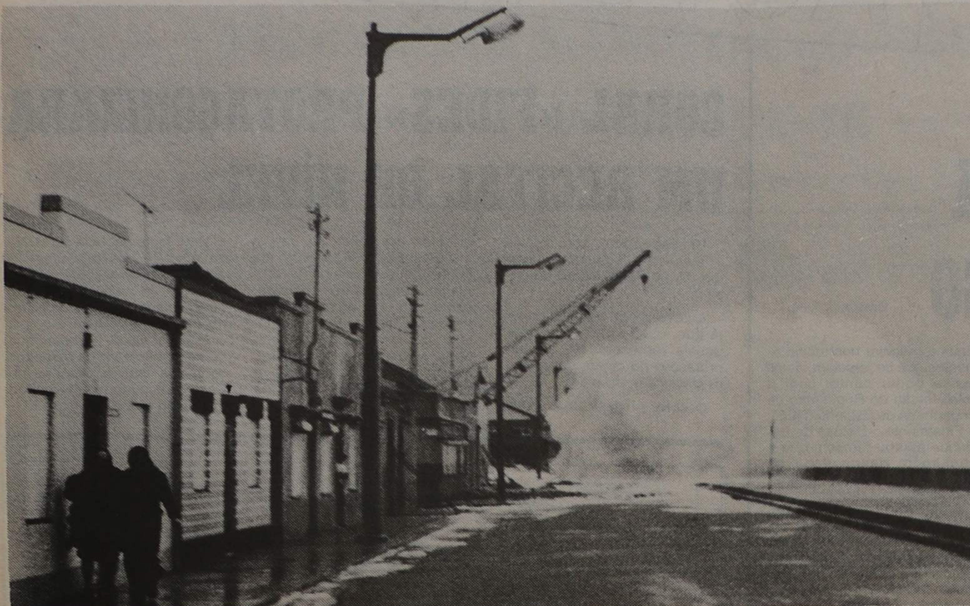
Reacondicionamento da defesa frontal e enchimento artificial da praia entre os dois grandes esporões - duas das obras a executar para que o cenário da foto (de arquivo) não se volte a repetir
