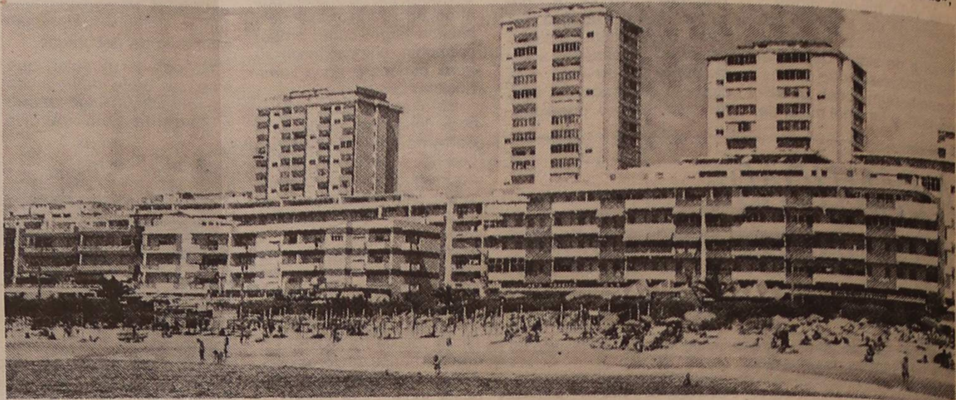
Se a sugestão interessar a Espinho, repare-se como se encara o urbanismo desta praia portuguesa (Quarteira) com uma orla marítima a deixar inveja: prédios de 4/5 andares, em cujos rés-do-chão funcionam, em belas esplanadas, restaurantes, cafés, pizzarias e outros estabelecimentos similares. Nos pisos superiores não faltam residenciais e apartamentos turísticos. Tudo isto numa avenida marginal de luxo. O que faz falta em Espinho
