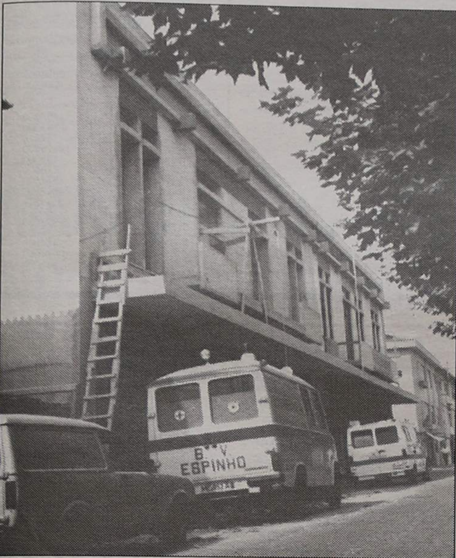
Obras no quartel dos Bombeiros Voluntários de Espinho.
