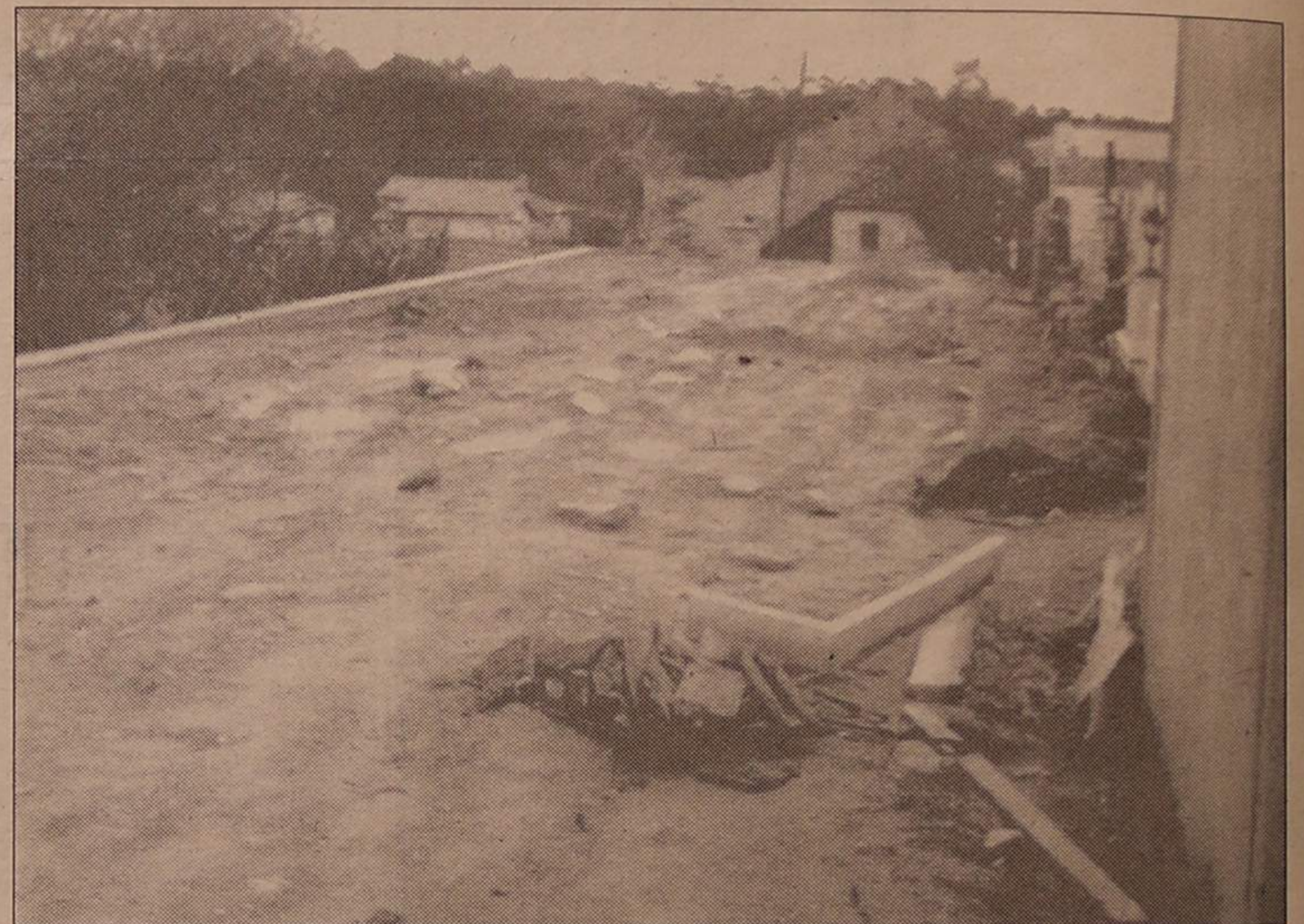
Vista parcial da 1ª fase, das obras no cemitério de Anta.
