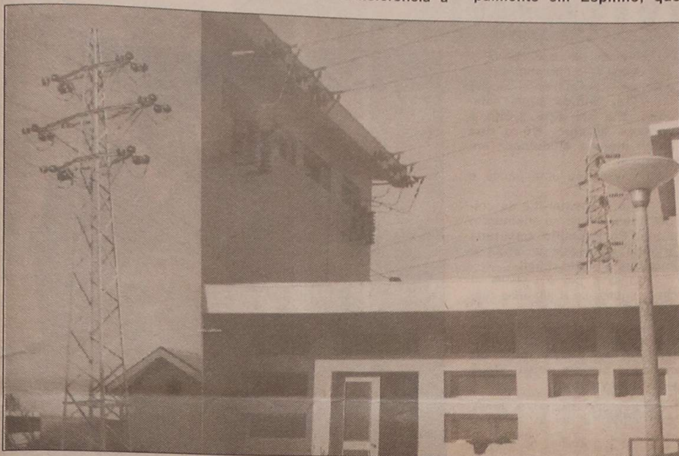
Redes aéreas serão substituídas por subterrâneas.
