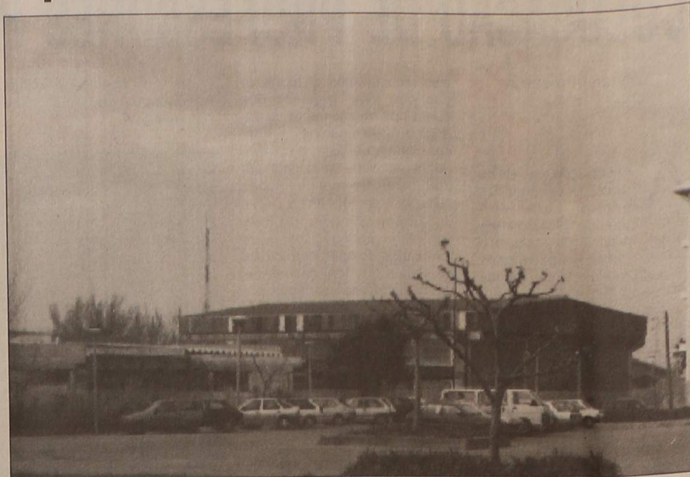
"A escola desde que foi construída ainda não sofreu obras de reparação"
