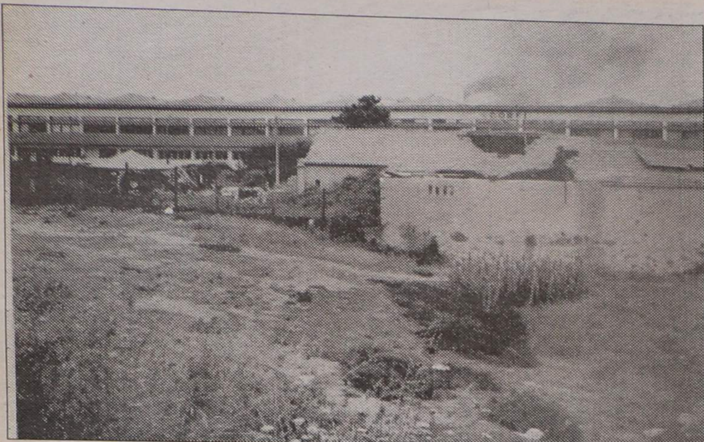
Velho edifício, à saída, serve de depósito de botijas de gás. É um verdadeiro paiol, com todos os riscos que daí advêm, tendo a poucos metros uma fábrica em permanente laboração, um talho, uma discoteca, etc.. No entanto, os responsáveis, não se mostram preocupados com o facto...
