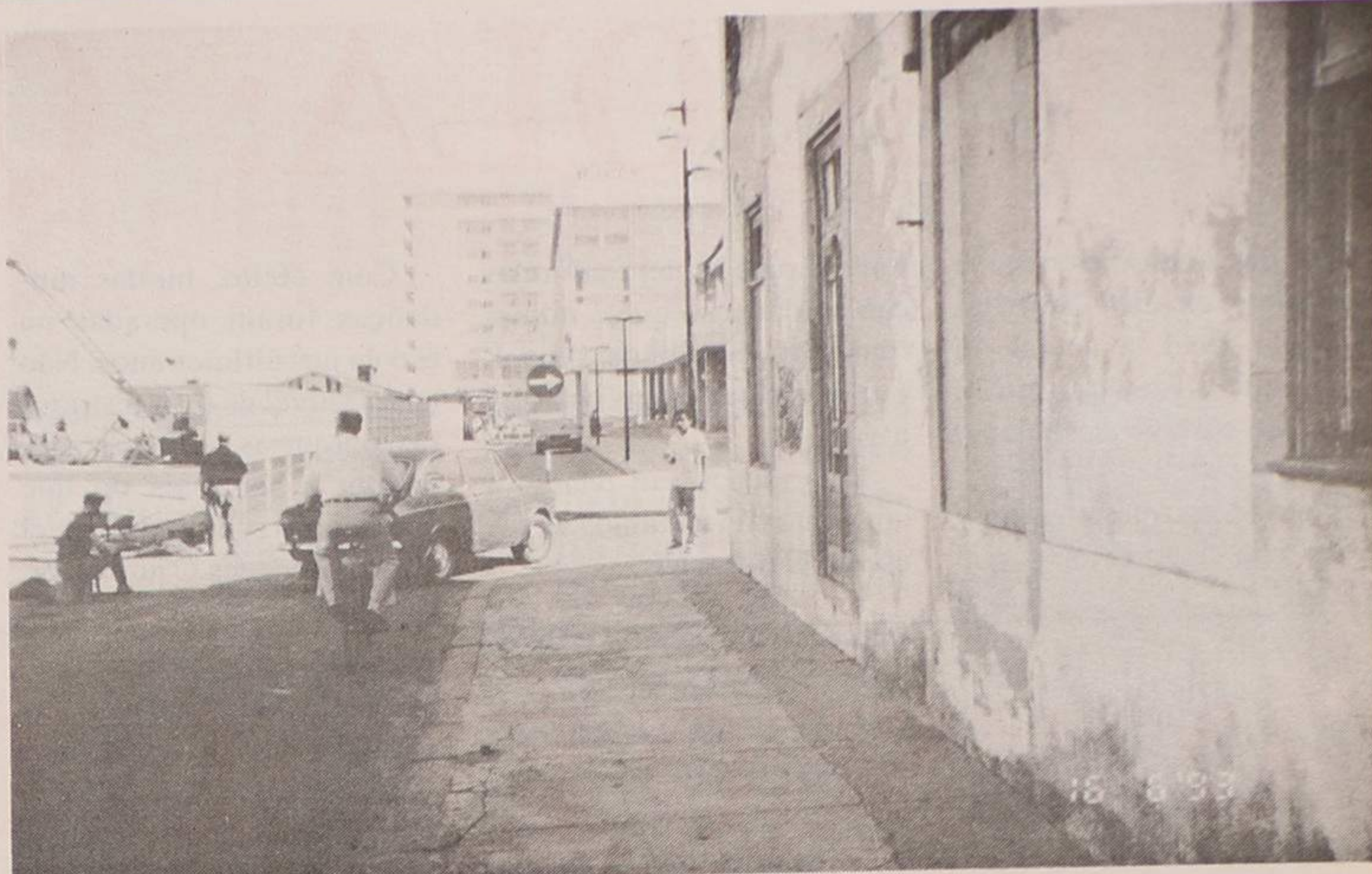
Circular na "4" junto às obras é um labirinto
