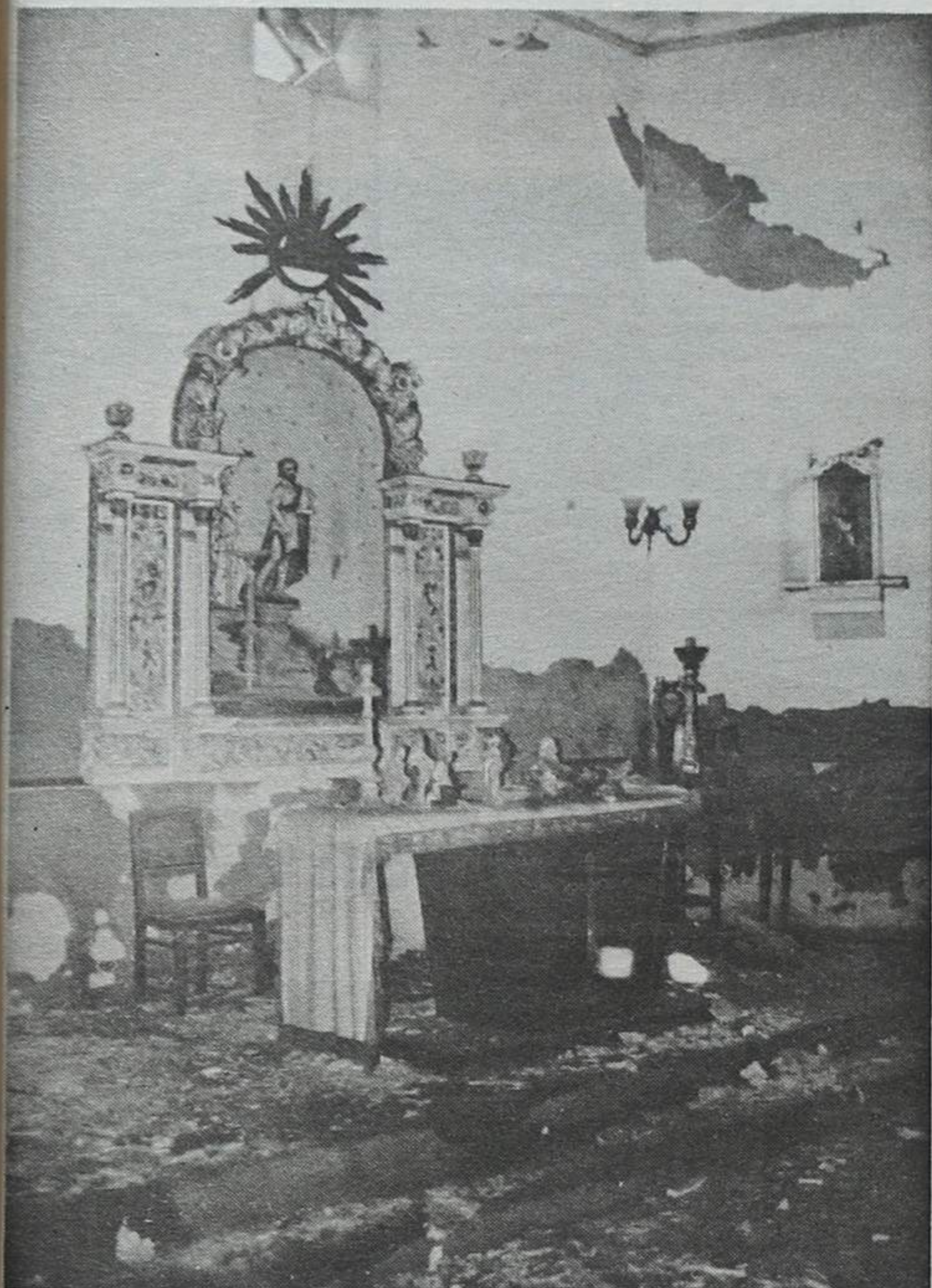
Estado degradado do interior da Capela de S. João
