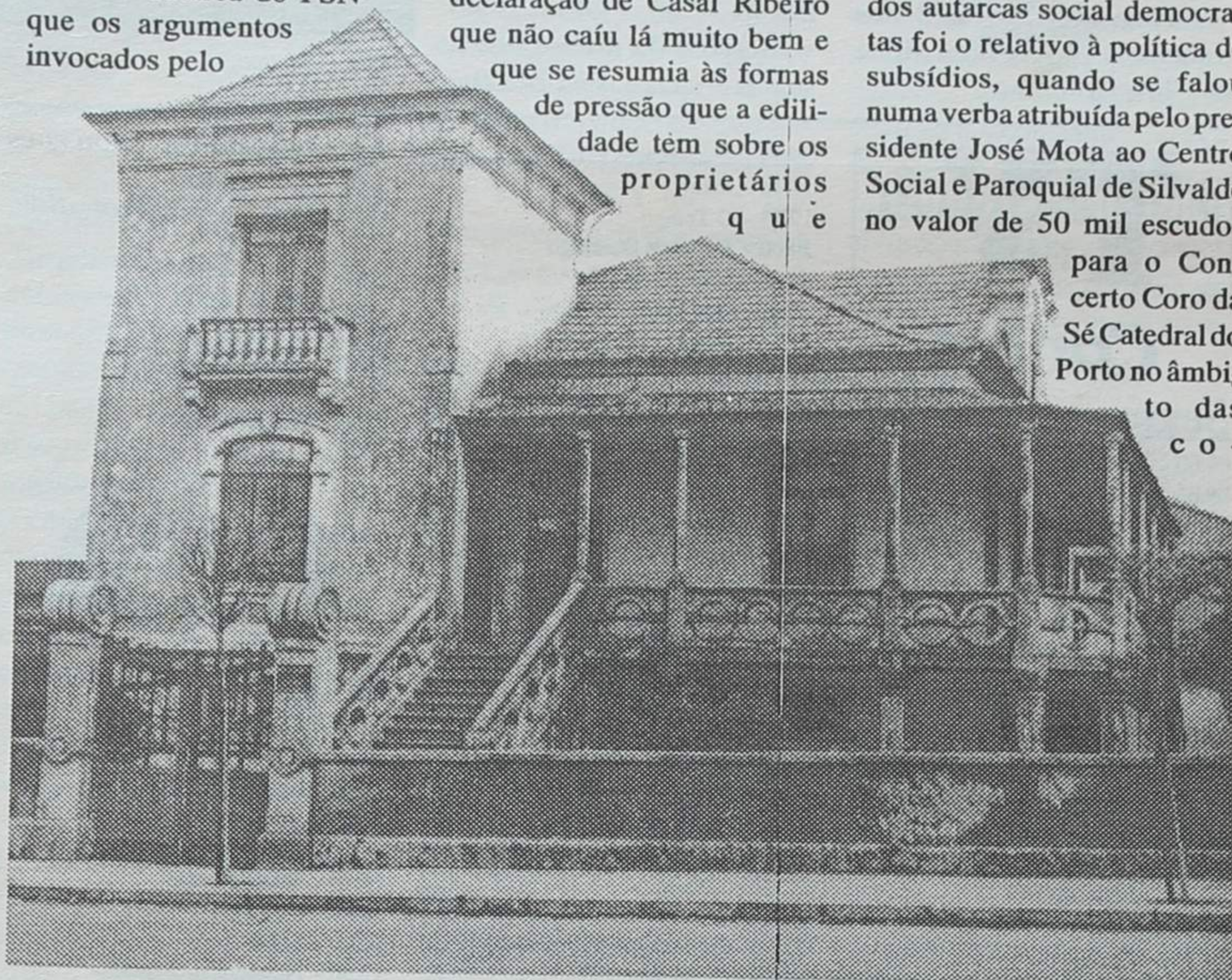
Edifício da Academia de Música vai ser demolido
