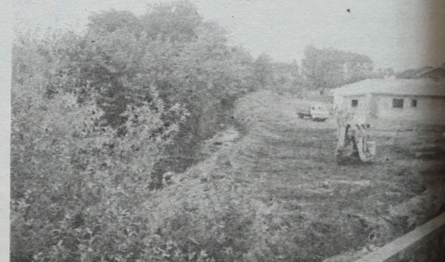
Limpeza e alargamento do rio Maior
