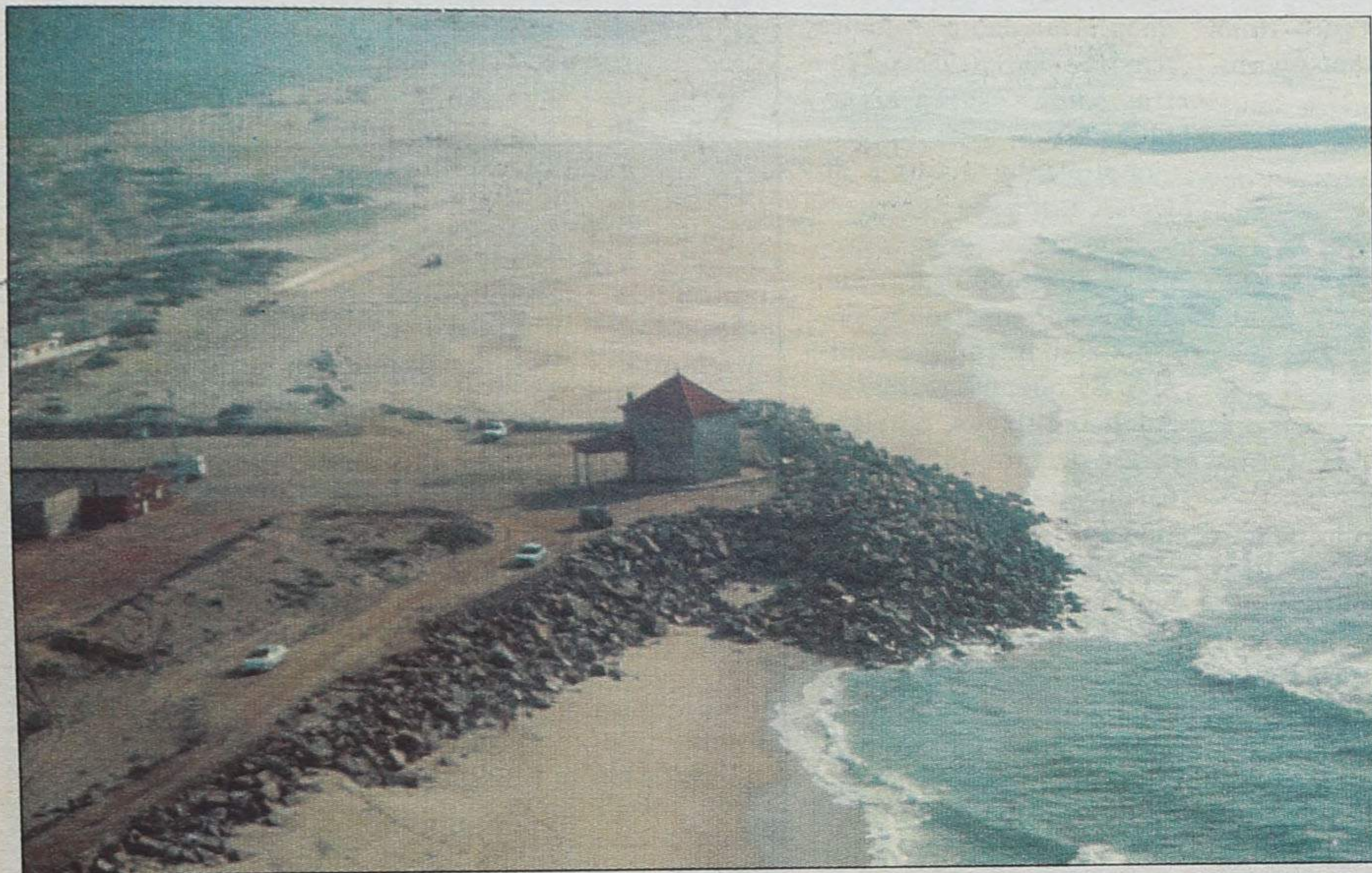
A capela de Paramos tem sido fustigada com os sucessivos avanços do mar
