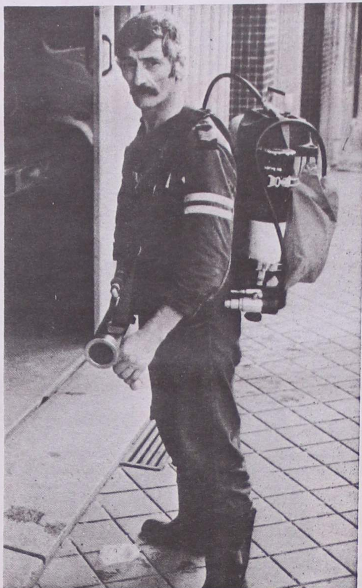
A "maquineta" dos "Voluntários Espinhenses" é simples mas eficiente. A parte de depósitos - 12 litros de água e ar para 18 "tiros" - é transportada, facilmente, às costas do bombeiro
