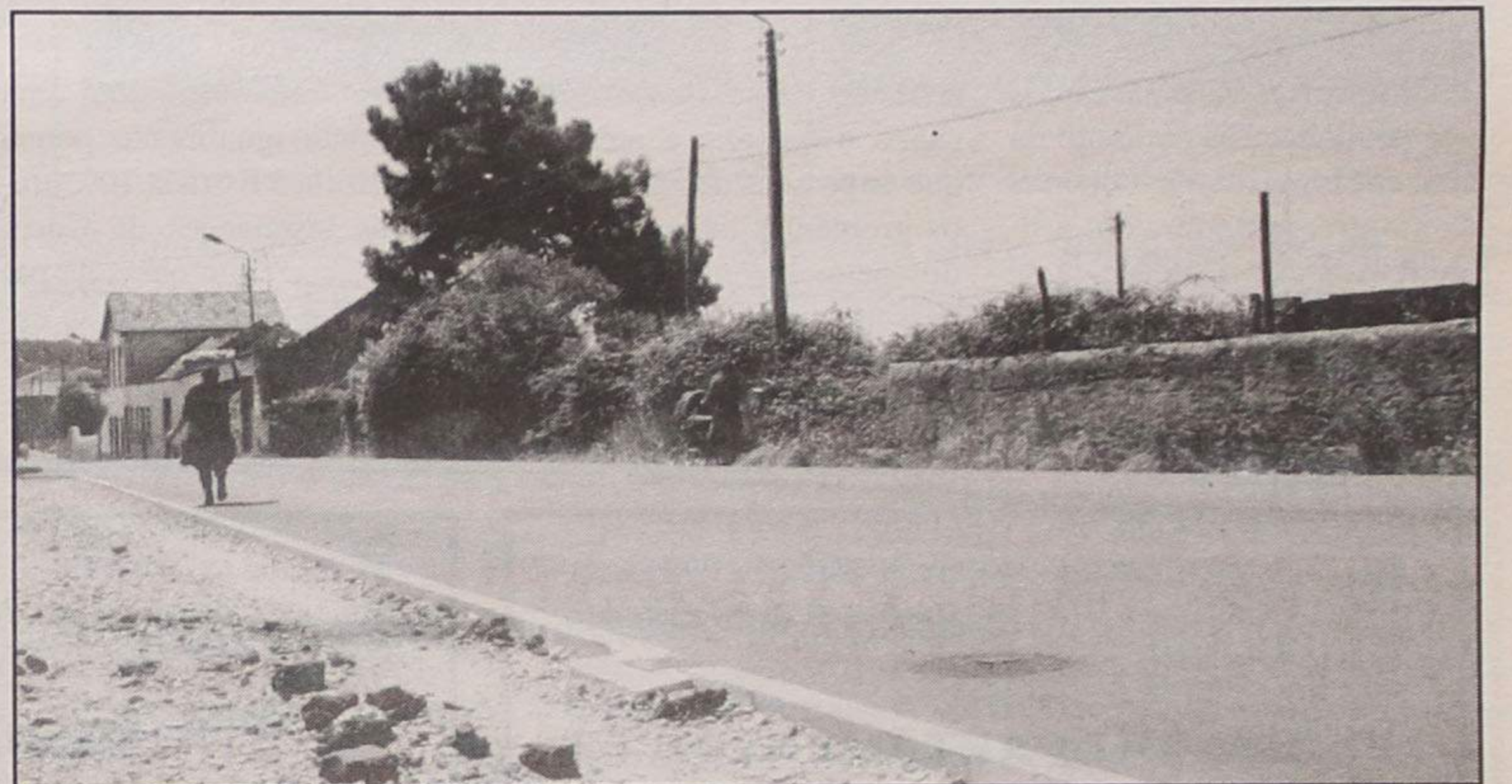
Entrada na cidade pelo lado sul. As pessoas são forçadas a caminhar pelo centro da via, porque o passeio tarda em ficar pronto. Do lado esquerdo vai uma peixeira; do outro lado, uma senhora com carrinho de bebé
