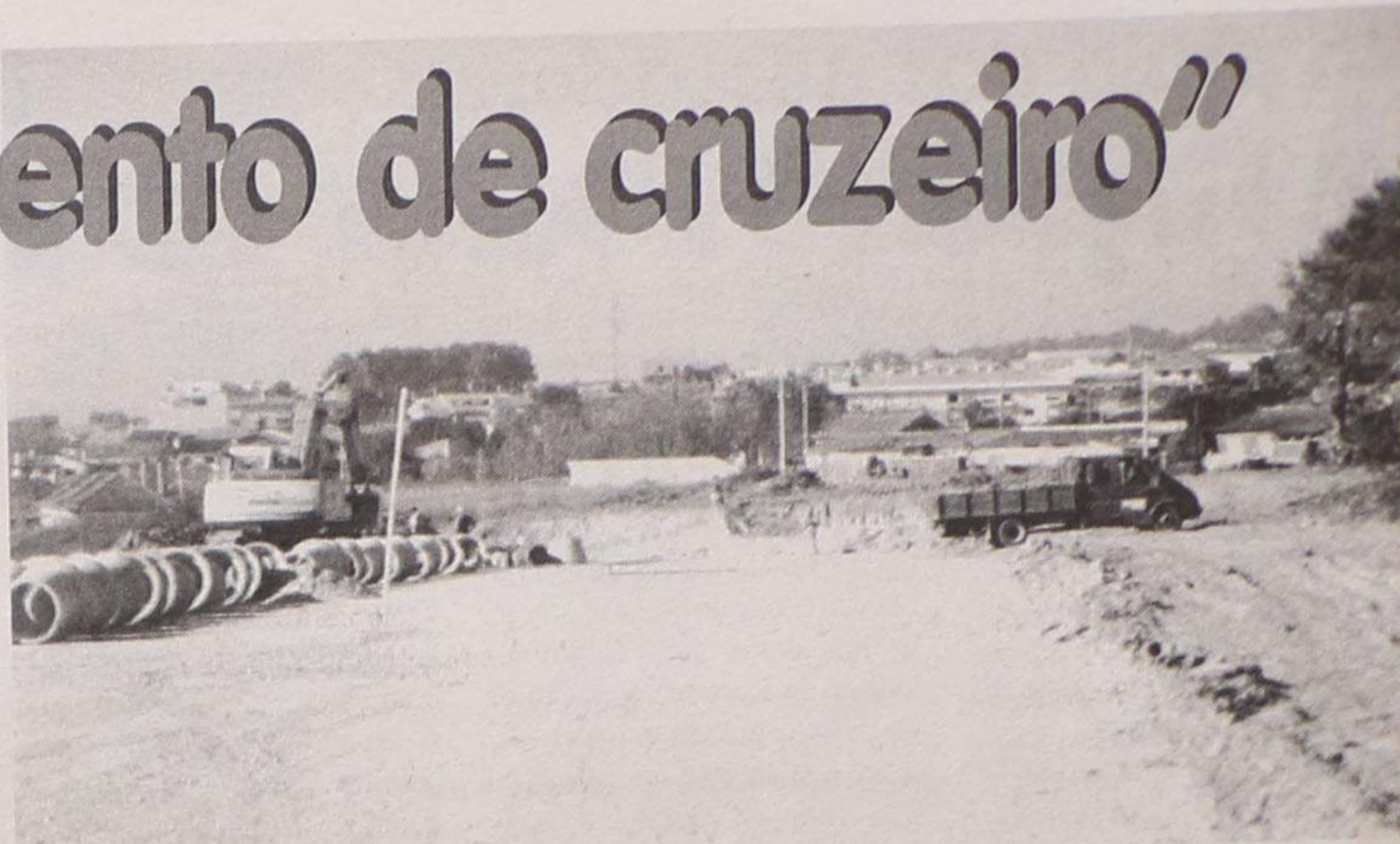
A Norte, as obras na Rua 32 prosseguem
