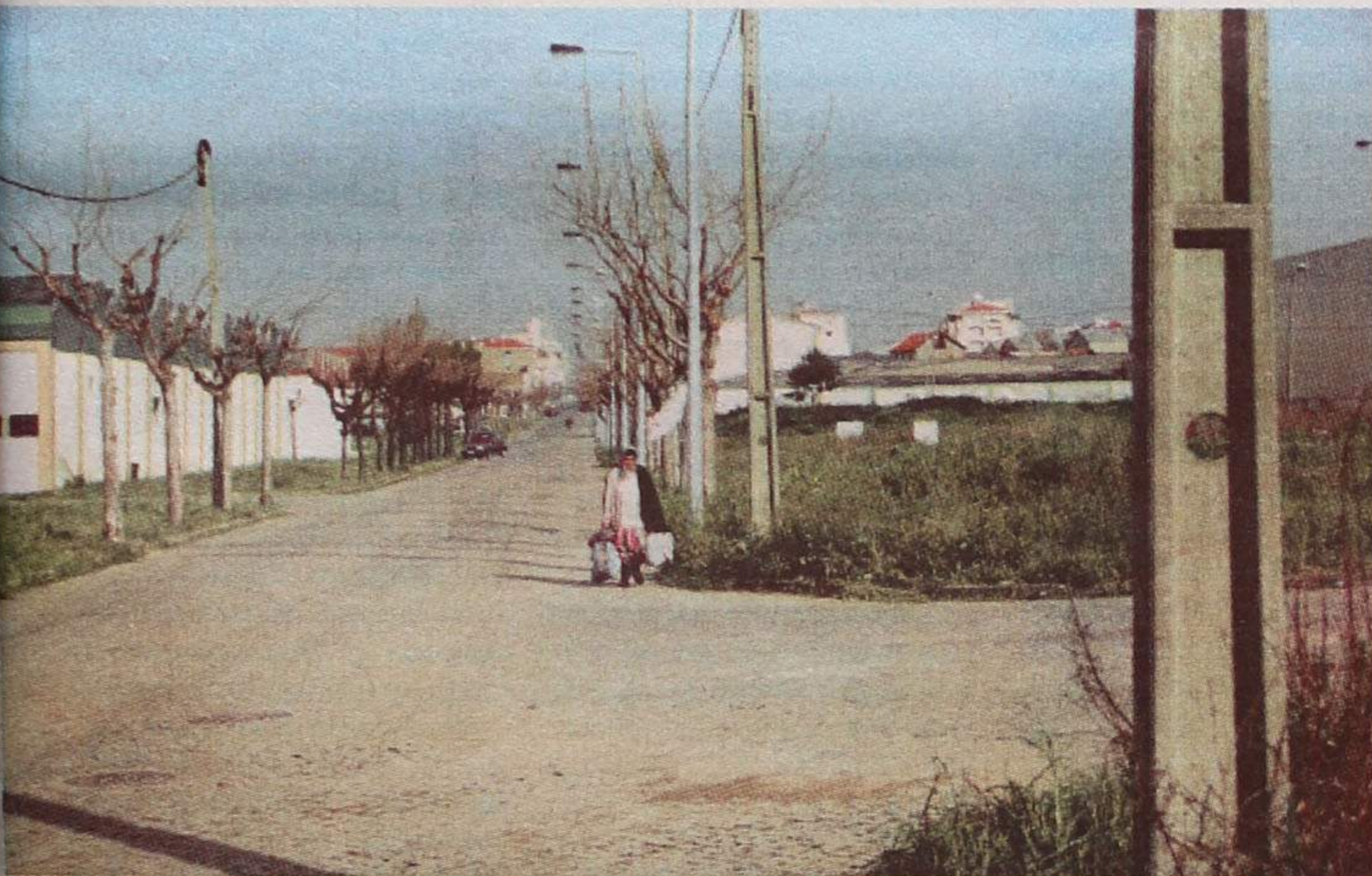
A ausência de passeios coloca em risco a segurança dos transeuntes
