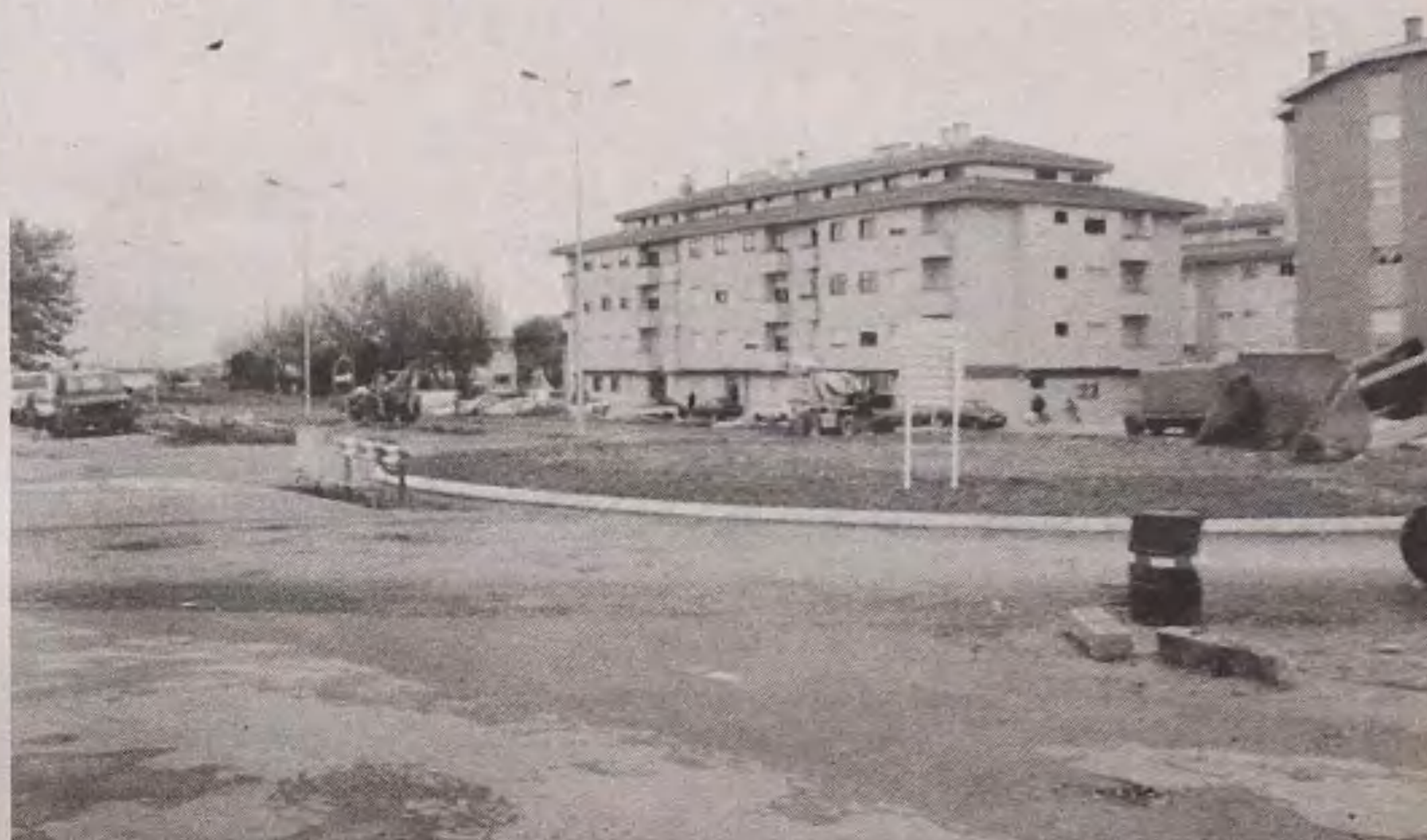
A Câmara Municipal de Espinho encontrou uma solução para evitar grande velocidades na Rua 32. No cruzamento com a Rua 33, começou a construir uma rotunda, a primeira do género que existe no nosso concelho.
