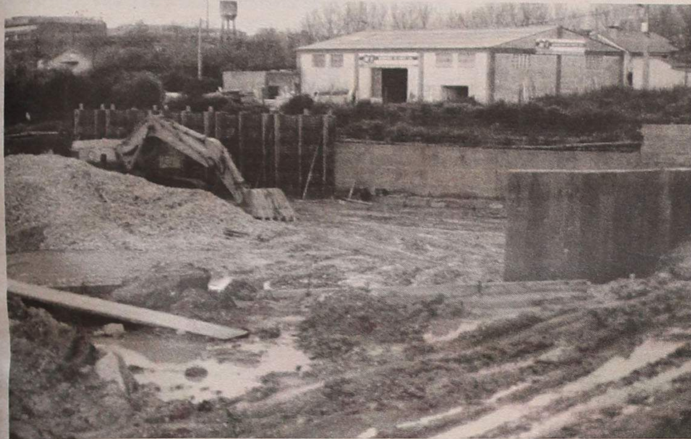
O local onde está a ser construído o Ecoponto
