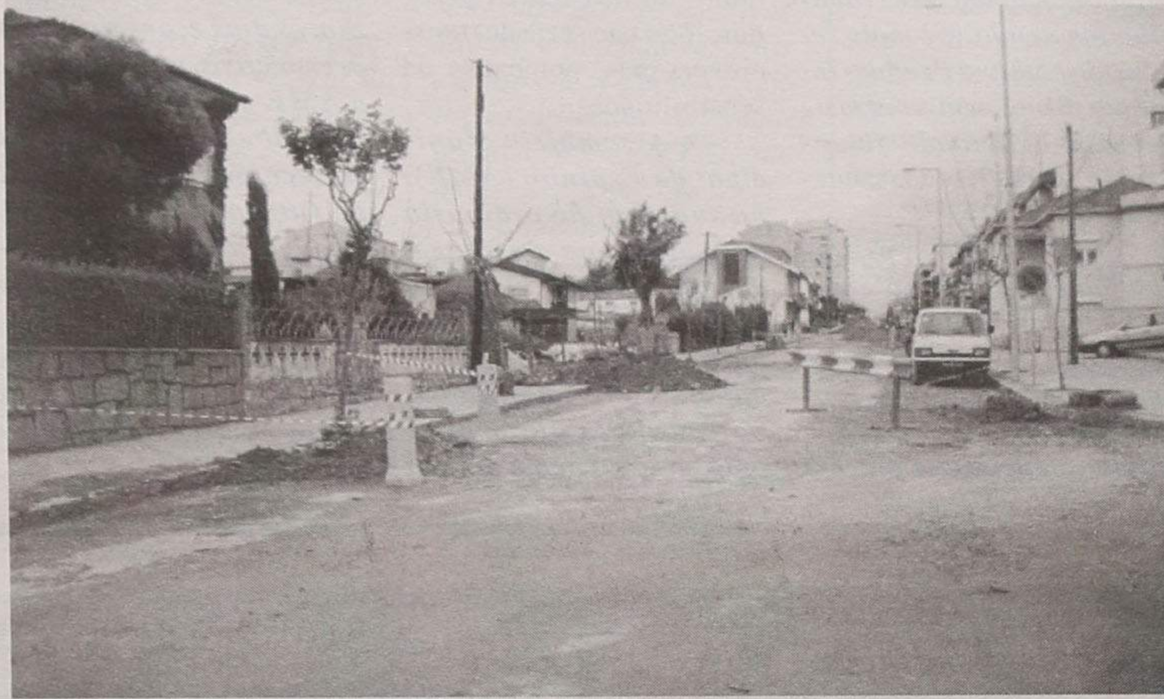
O dia 20 de Julho é o prazo limite para conclusão da empreitada
