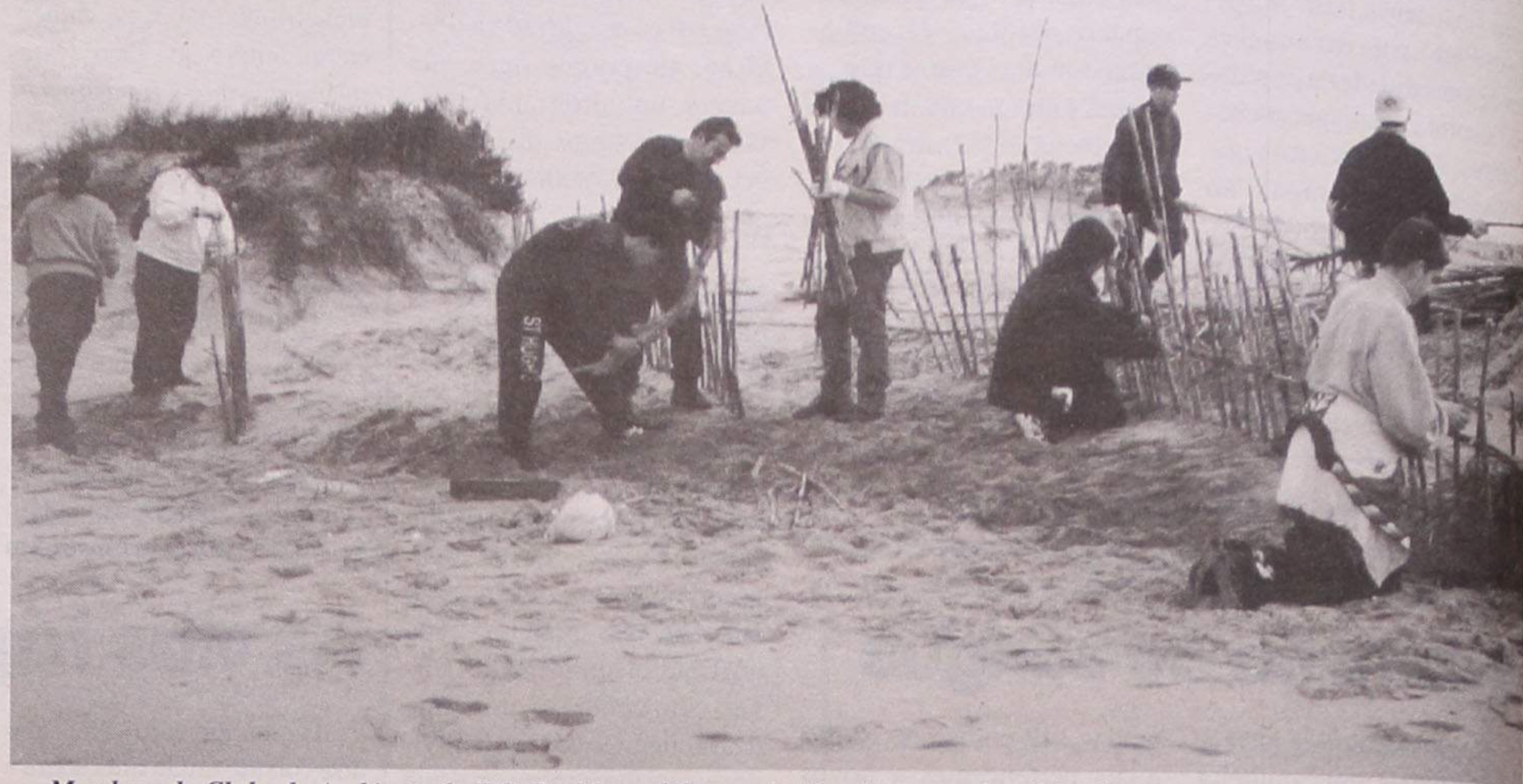
Membros do Clube do Ambiente da E.S. Dr. Manuel Gomes de Almeida, procedem à implantação de paliçadas de canas para reconstrução de duna junto ao topo norte do aeródromo de Paramos
