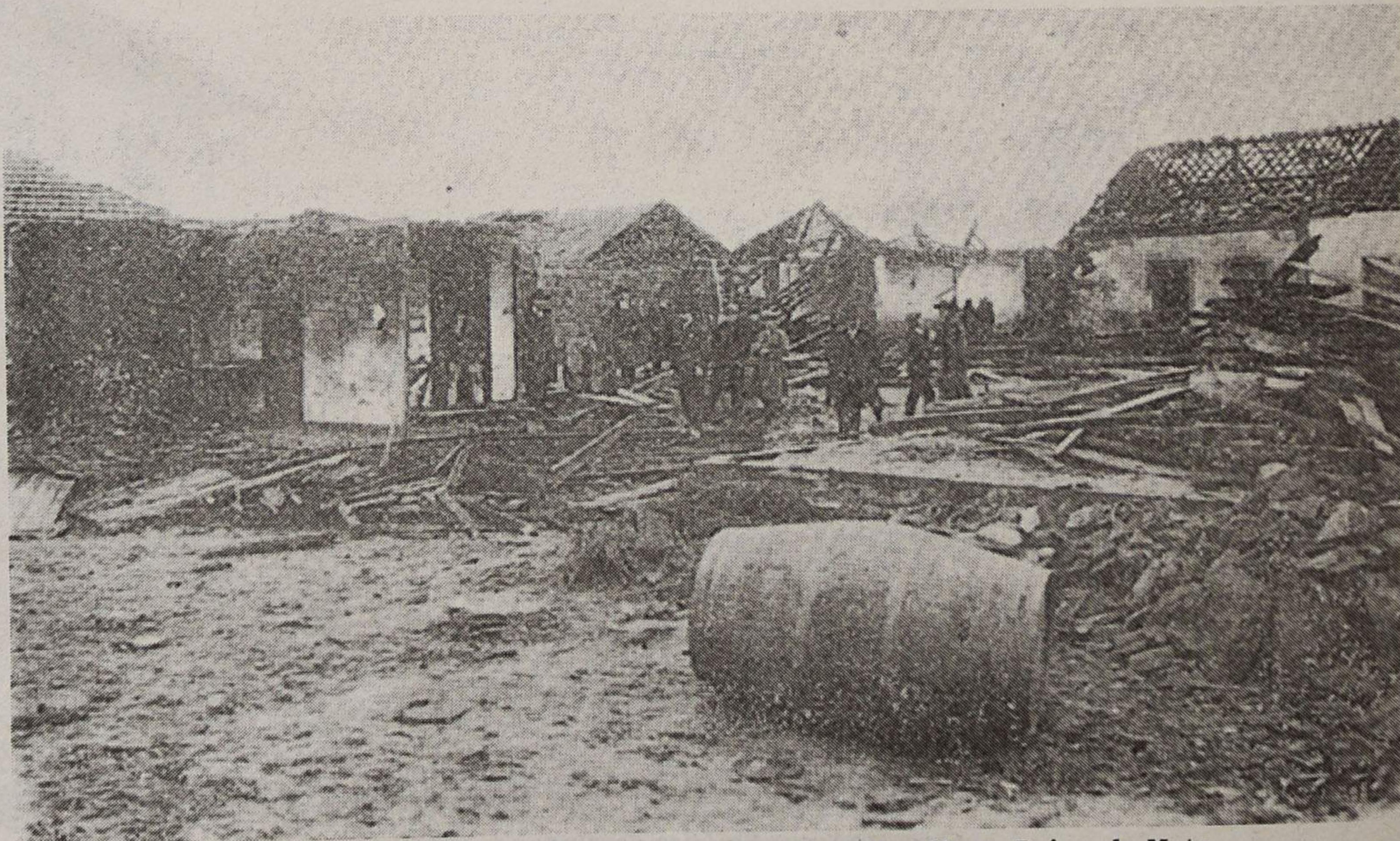
1925 - 20 de Dezembro - Os estragos causados pelo tufão no Bairro da Mata
