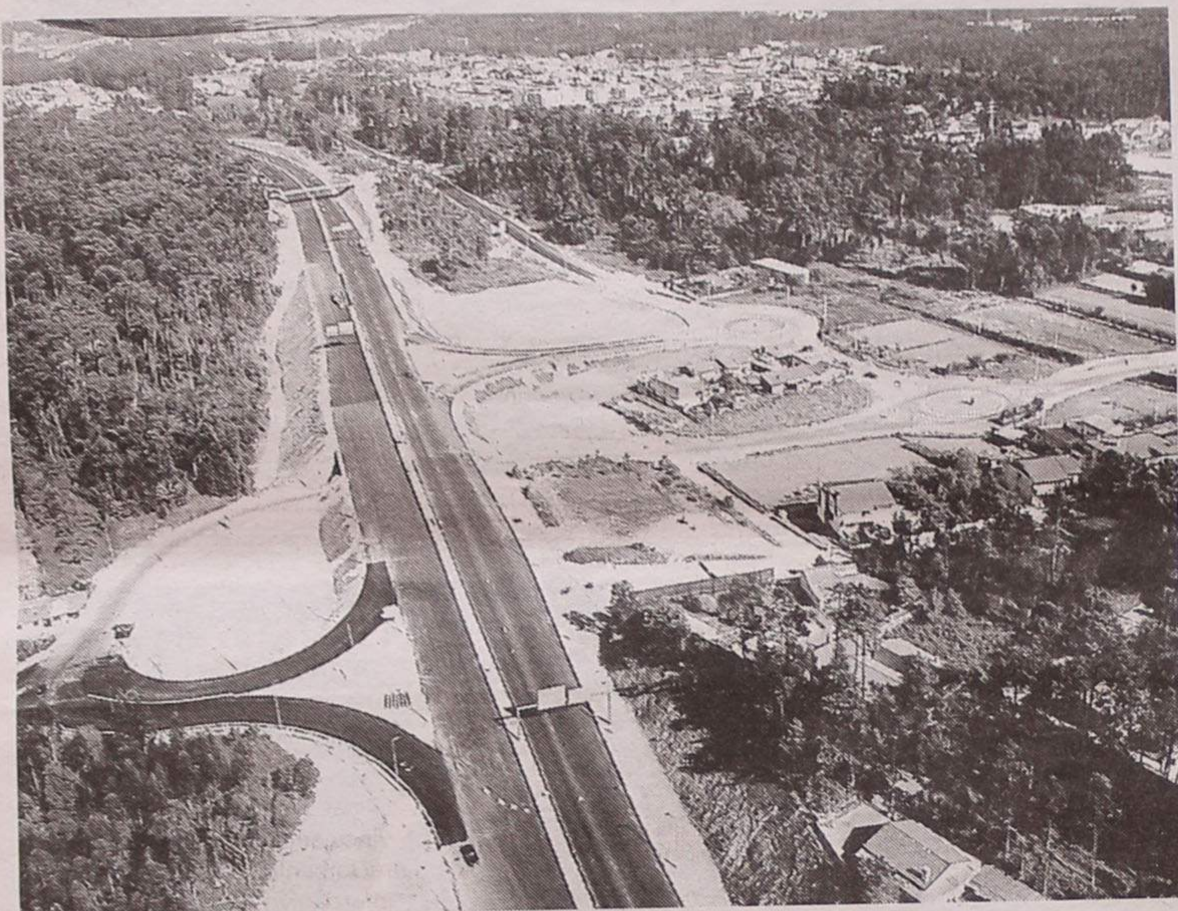
O IC24 terá quatro vias (duas em cada sentido) e o acesso com a Rua 19 será feito por uma rotunda com o 'trevo', com ligação ao IC1
