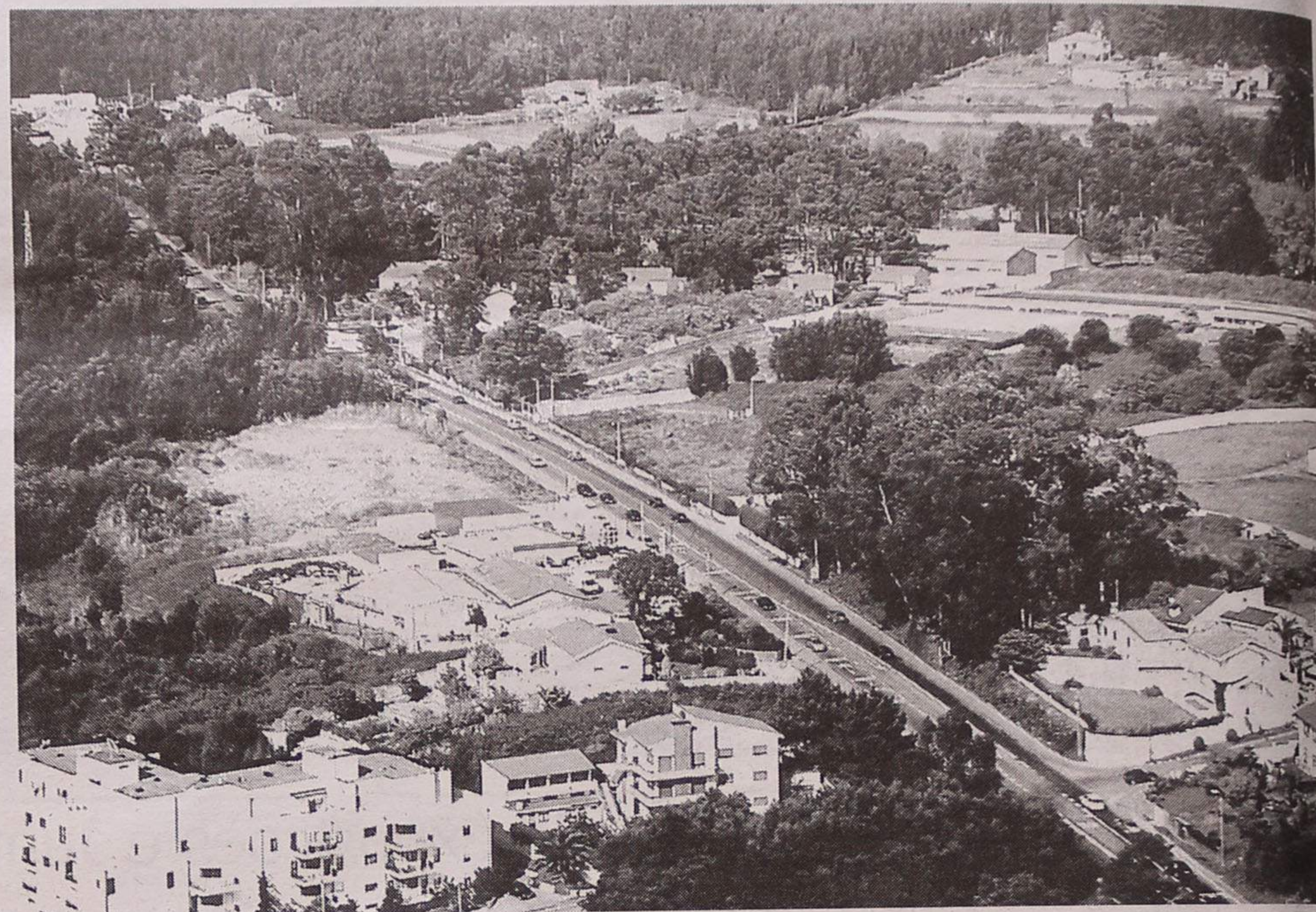
Duas boas alternativas ao IC1 em obras – a antiga estrada Espinho-Porto e a marginal
