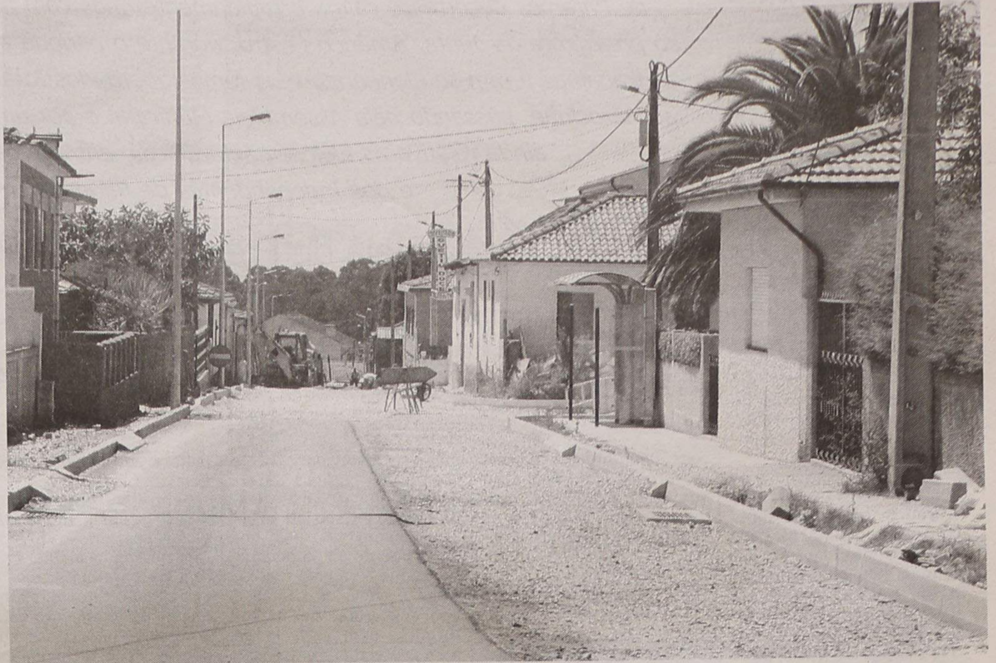
Apesar da primeira camada de asfalto ter começado a ser colocada, a Rua dos Combatentes continua a preocupar Junta e Assembleia de Freguesia de Guetim, pois nove meses depois do início das obras ainda há muito para fazer!
