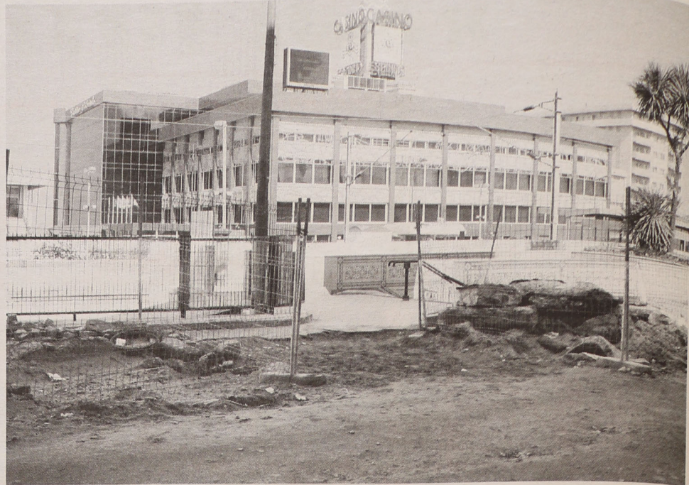
Para satisfação dos transeuntes foi aberto um acesso directo da passagem subterrânea para a Rua 8, só é pena que ninguém, consiga por lá passar sem sujar os sapatos
