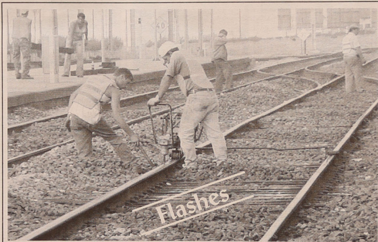
(Já) há obras na linha-férrea...
