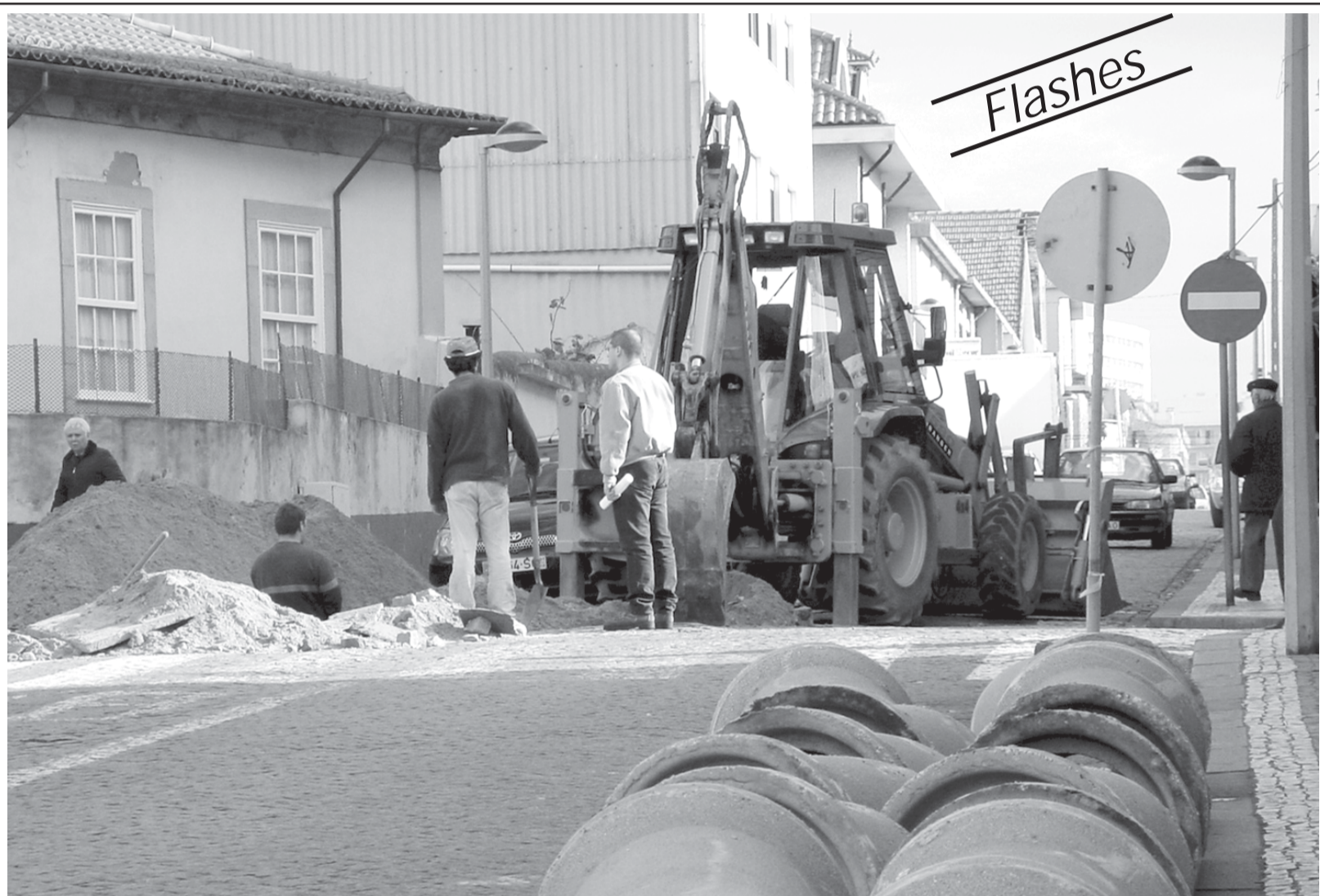
Com as obras da requalificação urbana em curso, ainda, a Sul da Rua 19, começou na terça-feira a intervenção a Norte, na Rua 15, com a colocação de tubos
