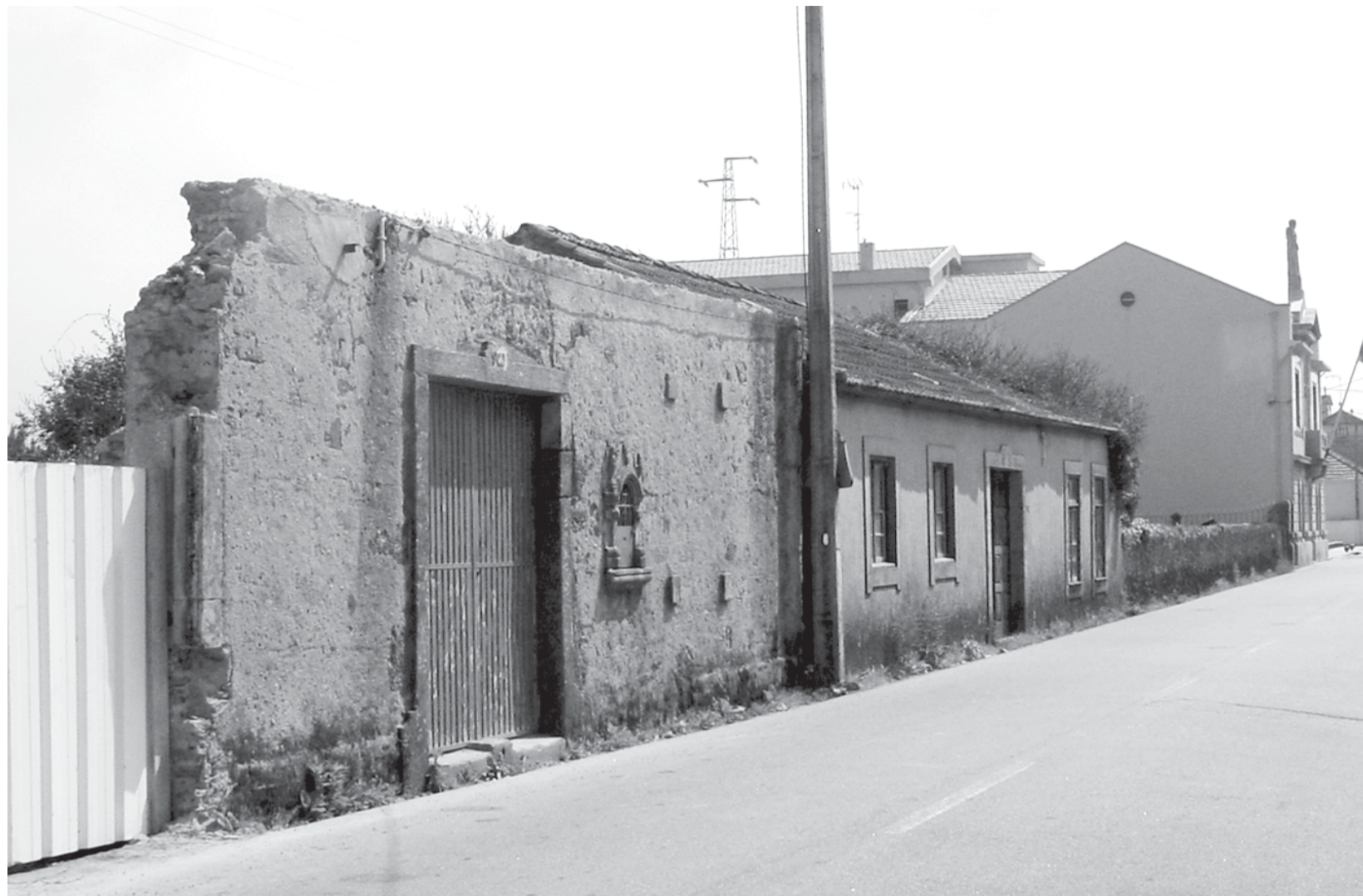
A obra de construção do edifício onde será instalado o ATL e infantário da Associação de Socorros Mútuos já começou
