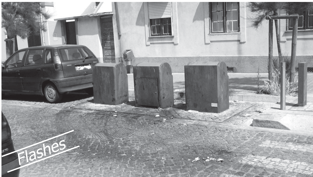
Os contentores localizados na esquina da Rua 23 com a rua 4 encontram-se num estado lastimável, com sujidade e gordura incrustadas e que correspondem ao cheiro nauseabundo que os mesmos destilam
