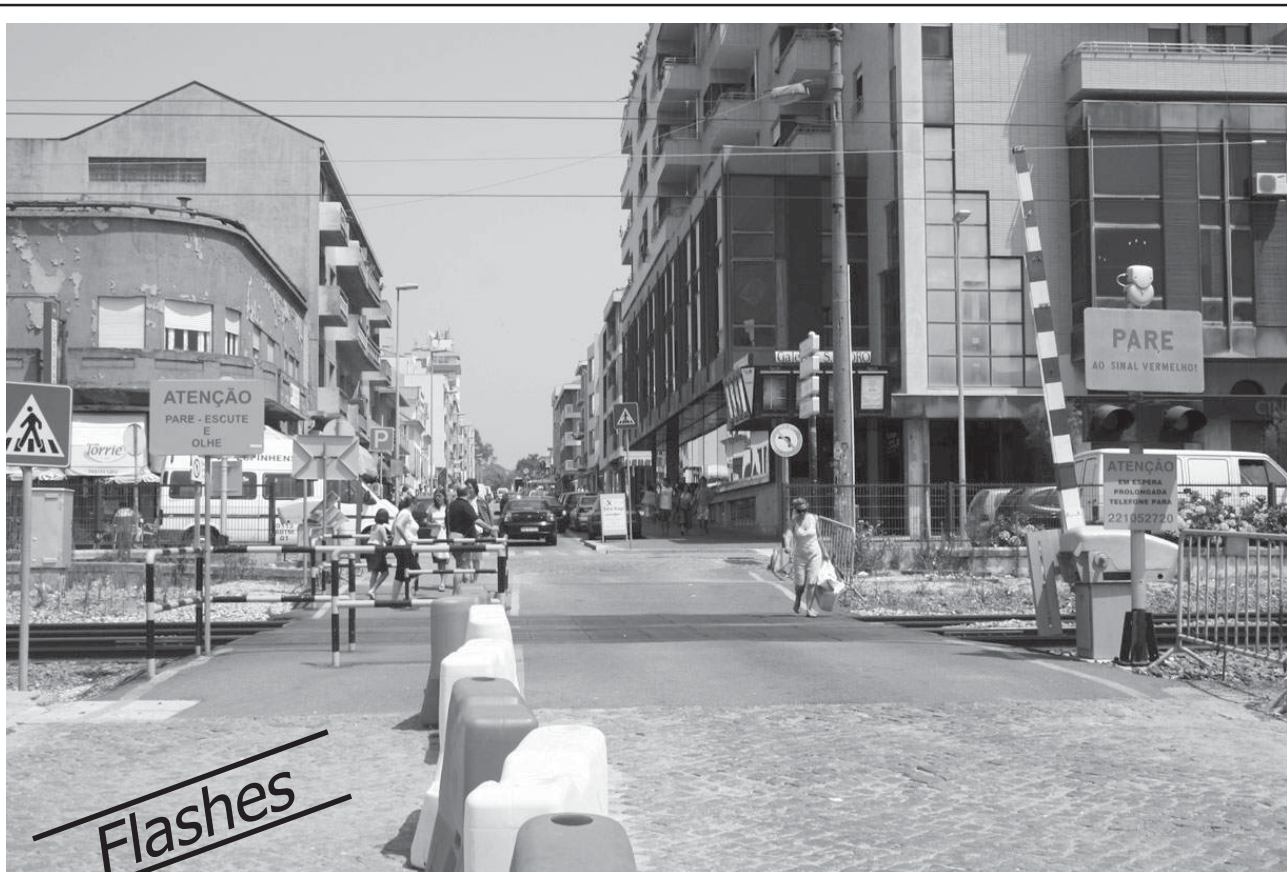
O sinal sonoro da passagem de nível da rua 23 que alerta para o encerramento das cancelas não se encontra em funcionamento, um perigo para as muitas centenas de peões que passam por aí diariamente, em especial os invisíveis
