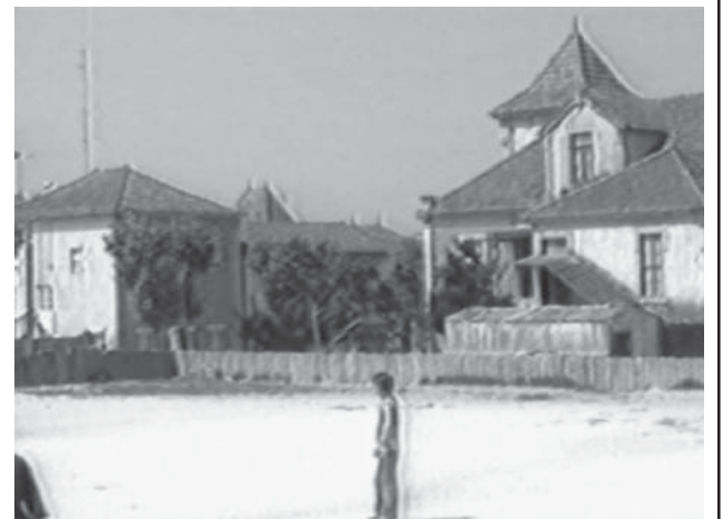
Vista parcial do edifício do campo de jogos a nascente, 1985
