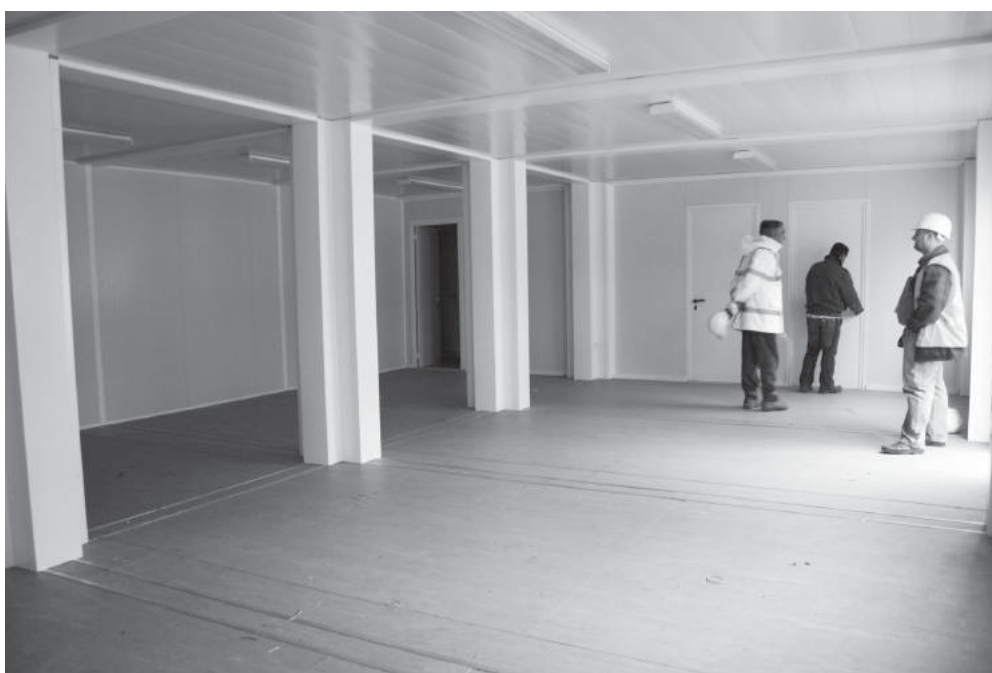
A estrutura onde irá assentar o novo edifício da estação, junto ao Hotel Nery (em cima); o interior da estação provisória que deverá entrar em funcionamento dentro de dias (em baixo)
