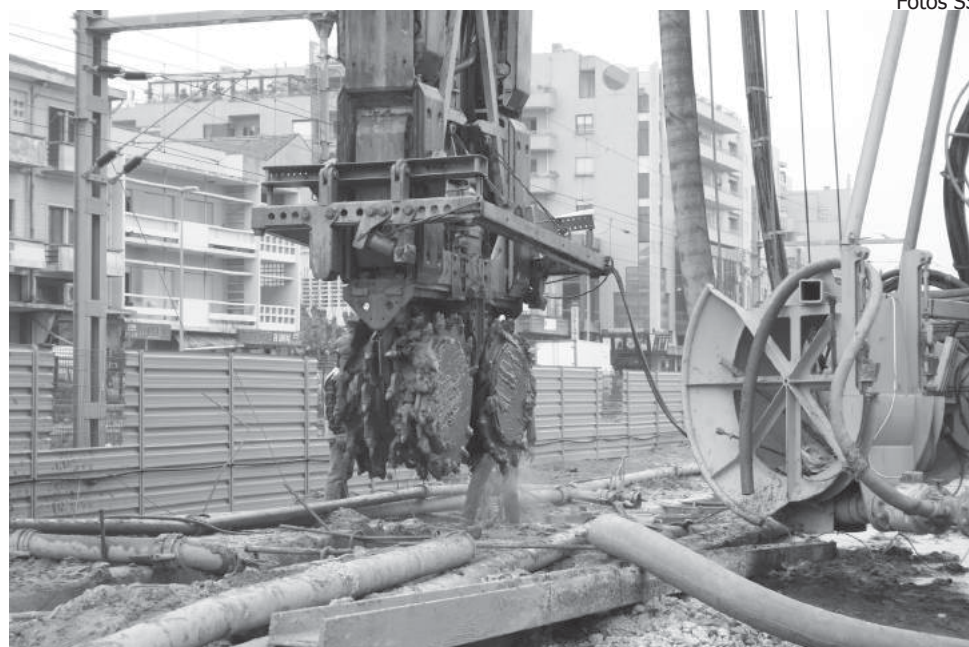
Os silos, dentro da obra, guardam e transformam o material (que é transportado através de uma extensa rede de tubos) extraído pela potente roda dentada da hidrofresa
