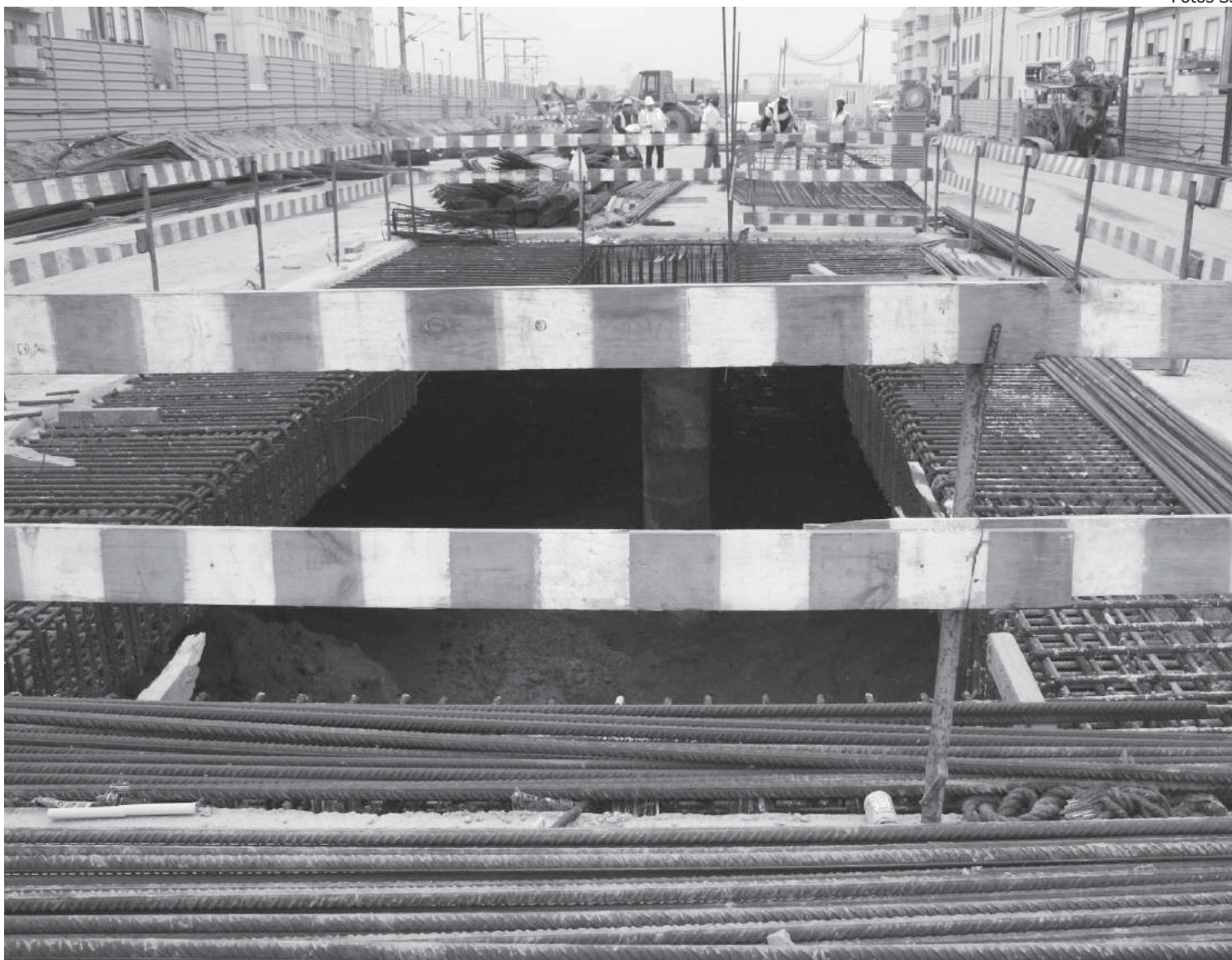
O túnel onde irá ser construído o cais de embarque e de desembarque foi construído com paredes de 2,80 metros e terá, também, escadas de emergência
