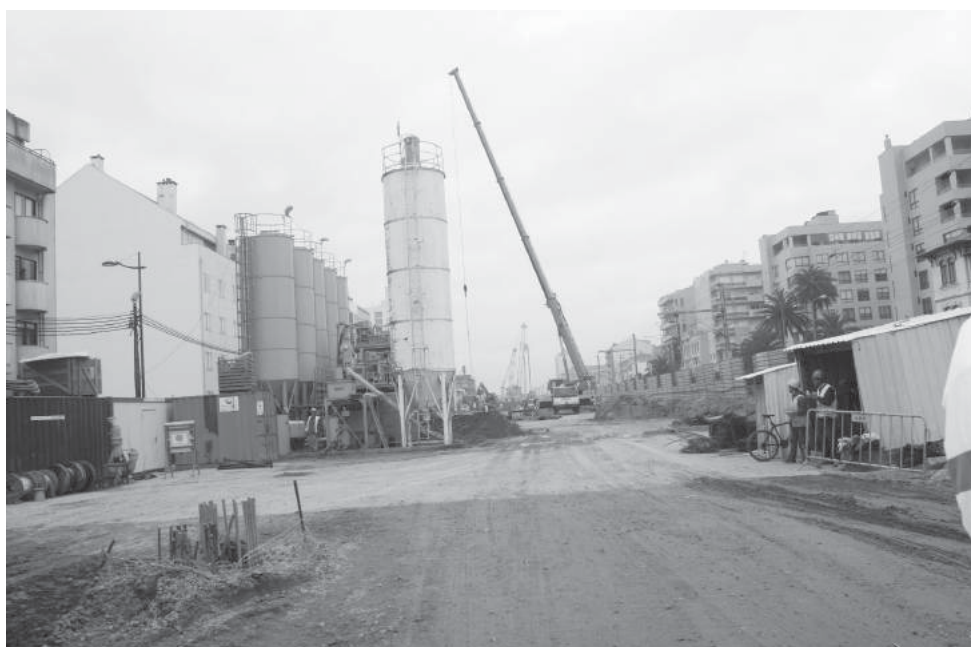
Os silos, dentro da obra, guardam e transformam o material (que é transportado através de uma extensa rede de tubos) extraído pela potente roda dentada da hidrofresa
