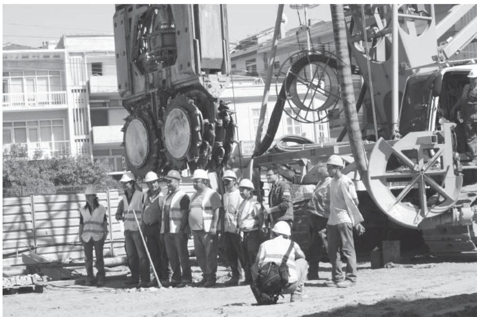
Foi por falta dela que a obra de enterramento da linha-férrea se atrasou e veio da Alemanha para abrir as valas, sobre a rocha, para o emparedamento do túnel.
