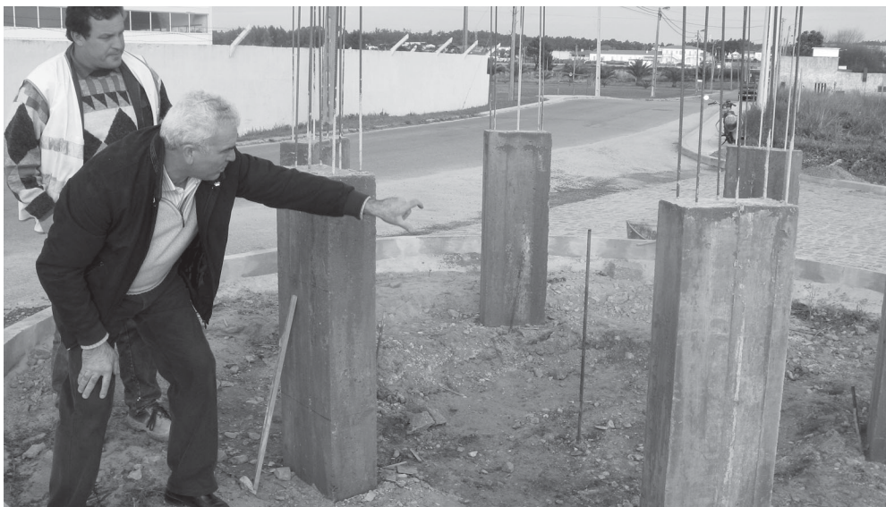
A Junta de Paramos está a construir a réplica de uma bateria anti-área na proximidade do Regimento de Engenharia
