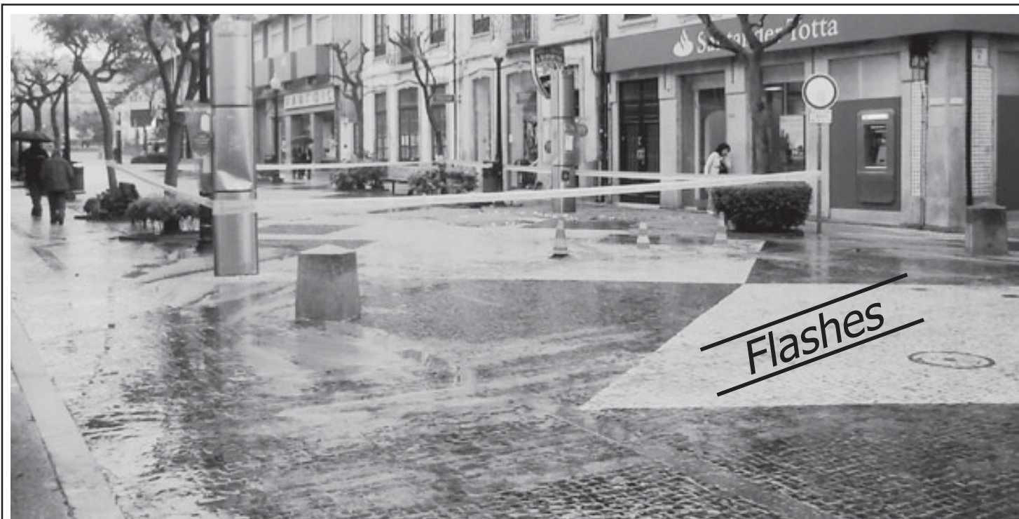
A conduta de água da Rua 19, em frente ao banco Santander, voltou a rebentar, na manhã de segunda-feira!...
