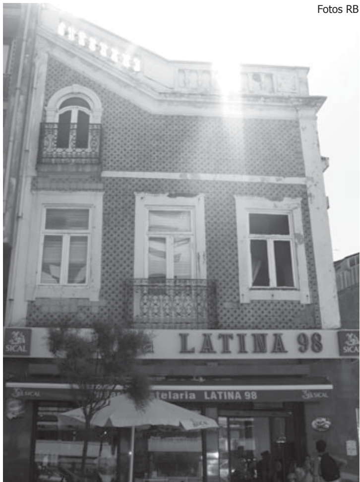
Fachada em azulejos floridos e varandins em ferro forjado
