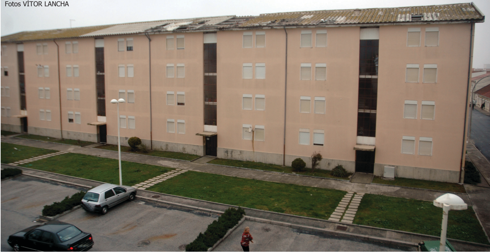
Telhado(s) danificado(s) no bairro social da Marinha
