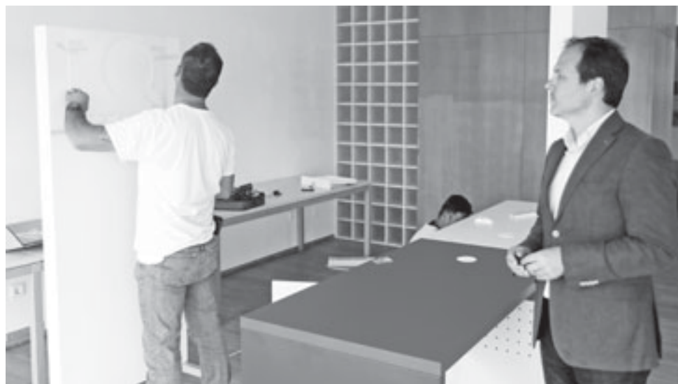
Vicente Pinto, vice-presidente da Câmara, na instalação do mobiliário e ligação a infraestruturas de eletricidade dos Espaços do Cidadão
