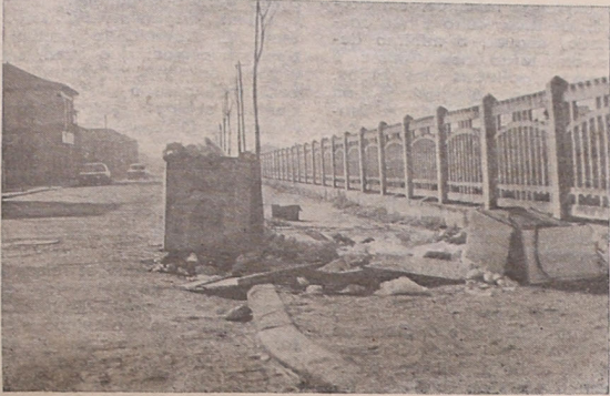
Junto a esta vedação se construirá a futura «Estação de Caminho de Ferro»
