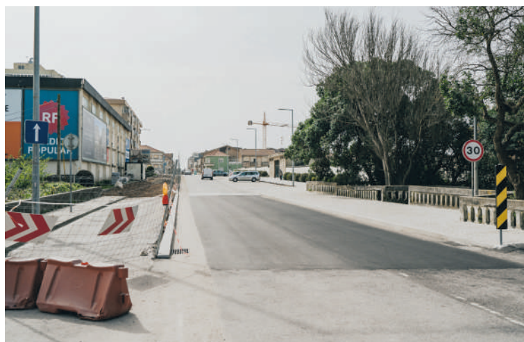
É junto ao cemitério, na Rua 20, que já se notam mudanças na intervenção desta via. No local, já há alguma sinalização, assim como uma lombada redutora de velocidade
