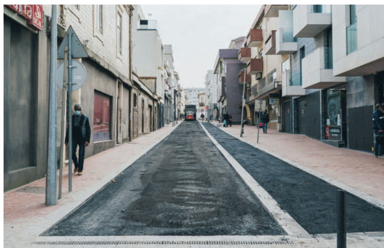
Nesta primeira fase, na Rua 21, foi tido em conta o piso automóvel que já sofreu intervenções, quer na parte de circulação, quer na zona reservada ao estacionamento
