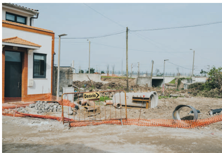
Já arrancou a construção da Praça do Rio Largo. Incluída no projeto do Recafe, esta intervenção vai criar uma zona de conforto agradável
