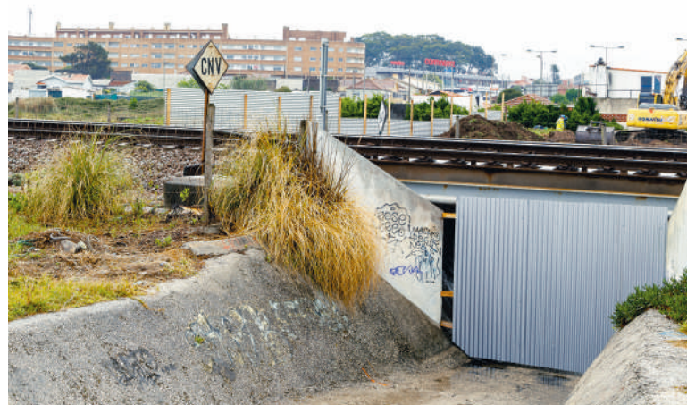
OBRA TEM UM PRAZO DE EXECUÇÃO DE DOIS ANOS
