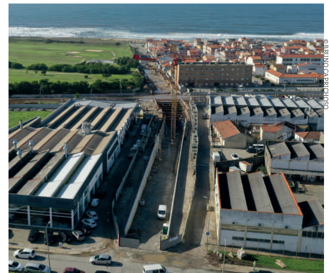
A IP reconheceu a necessidade de construir uma caixa de escadas a nascente e a ponte na passagem inferior para facilitar o atravessamento das pessoas
