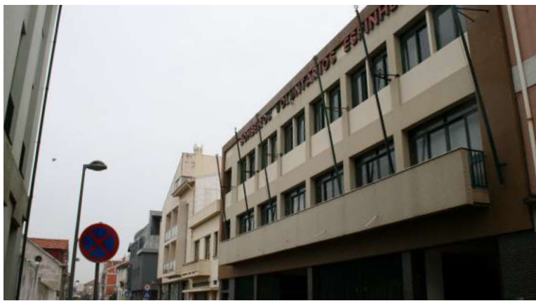
No quartel frontal à Igreja Matriz (em cima na fotografia) autarquia prevê criar apartamentos com arrendamento acessível. Espaço museológico para homenagear as duas extintas associações de bombeiros deverá surgir no antigo quartel dos Bombeiros Voluntários Espinhenses
