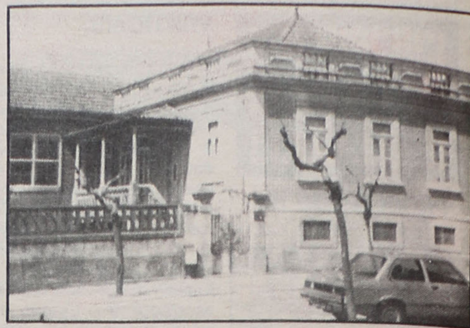
Um Centro de Saúde a substituir.
