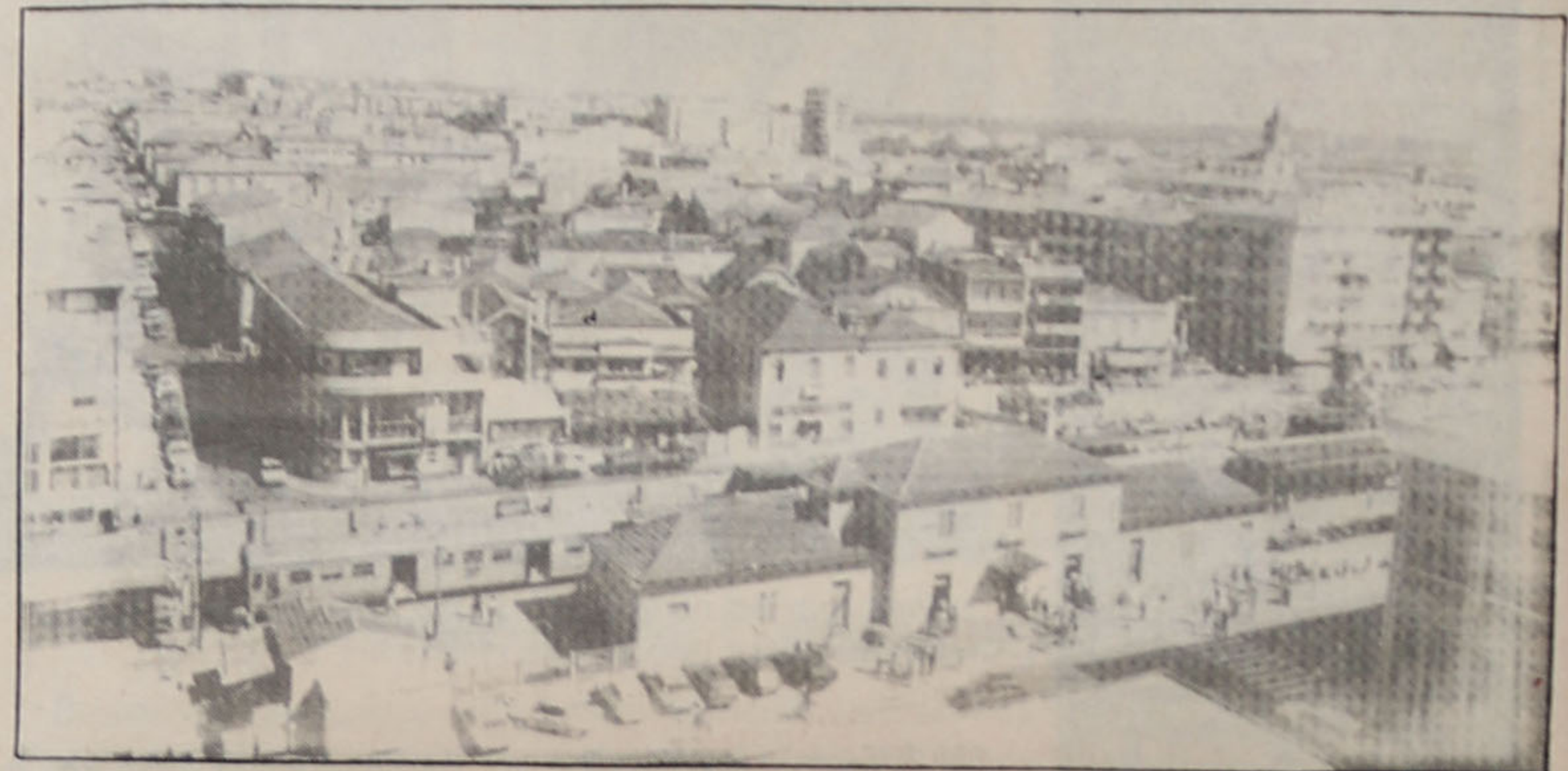
O Concelho de Espinho não foge à situação característica da Área Metropolitana: uma insuficiência significativa em matéria de infra-estruturas básicas.
