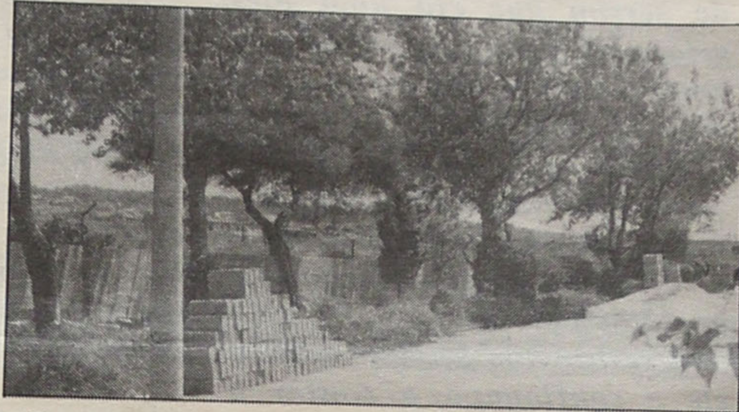
Parte do muro construído na sequência da "Campanha do Tijolo".
