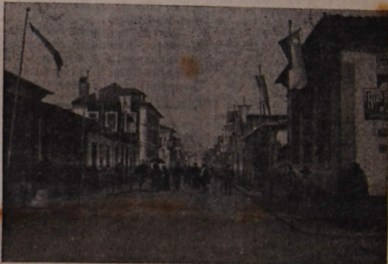
A antiga Rua do Cruzeiro, hoje Rua 2, vendo-se ao fundo a última capela de N. S. da Ajuda, que o mar destruiu
