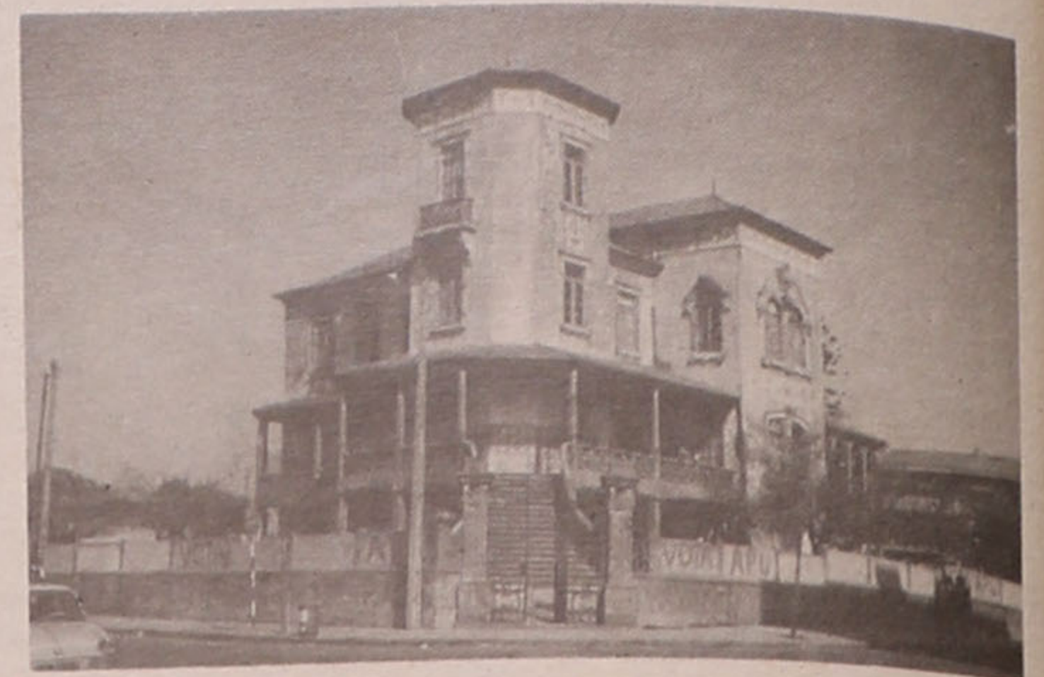
Palacete da Rosa Pena é o edifício ideal para se instalar a Casa da Cultura (1).
